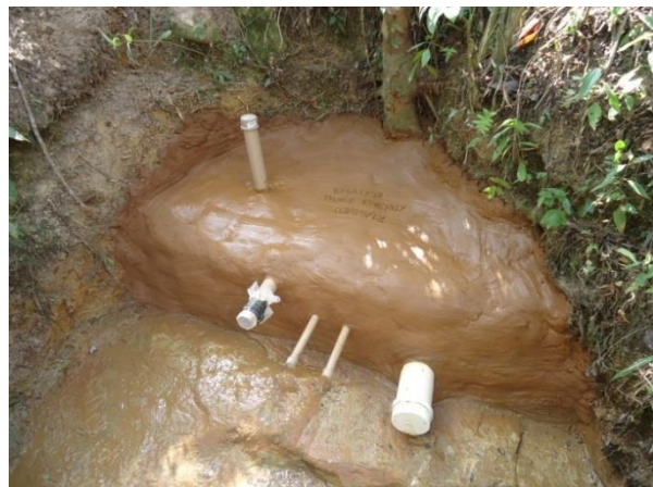
Foto 26 – Aspecto da proteção concluída, observando os canos devidamente fechados.
