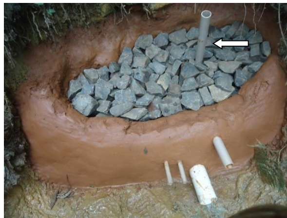
Foto 22 – Nascente preenchida com pedras. Observar o assentamento do cano suspiro (seta).
