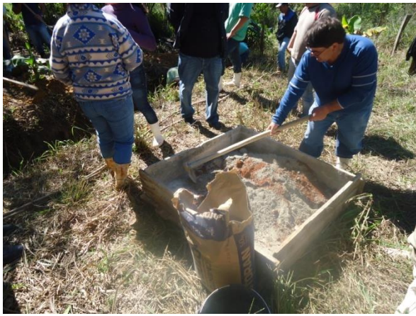
Foto 09 – Mistura de terra com cimento.
