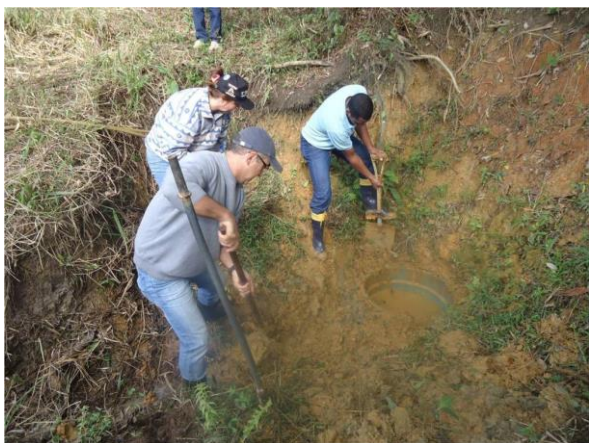
Foto 05 – Retirada de estrutura pré-existente e início da abertura de vala de escoamento.
