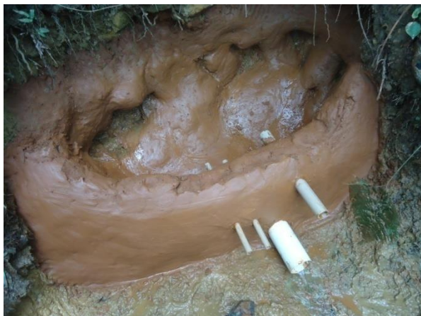
Foto 21 – Aspecto da nascente antes da colocação das pedras.
