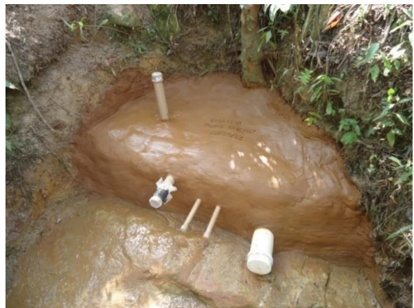
Fotos 31 e 32 – Trabalho de proteção de nascente realizado na propriedade do Sr. José Pedro dos Reis Filho - Município de Tomazina/PR (aspecto antes e depois)
