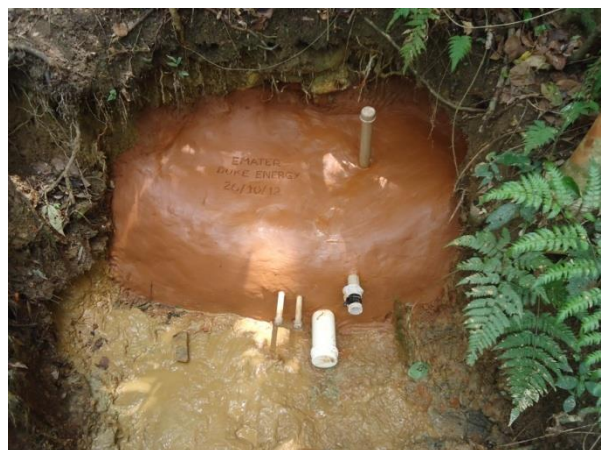
Fotos 33 e 34 – Trabalho de proteção de nascente realizado na propriedade do Sr. Cristiano Daniel da Silva - Município de Tomazina/PR (aspecto antes e depois)
