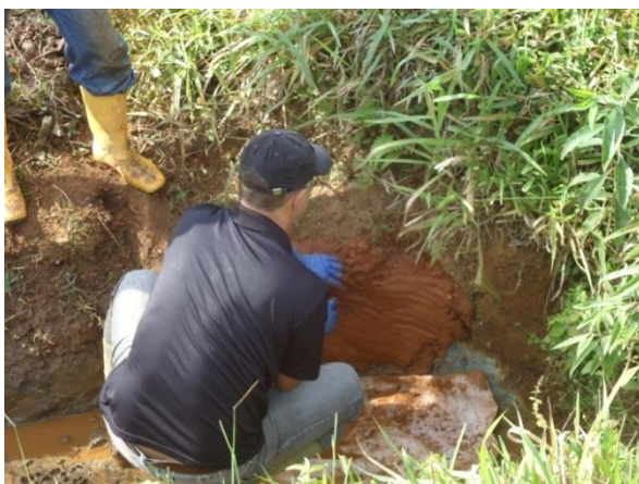
Foto 13 – Reboco das paredes do barranco.
