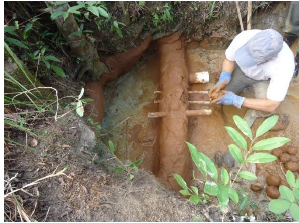
Foto 18 – Assentamento do cano ladrão.
