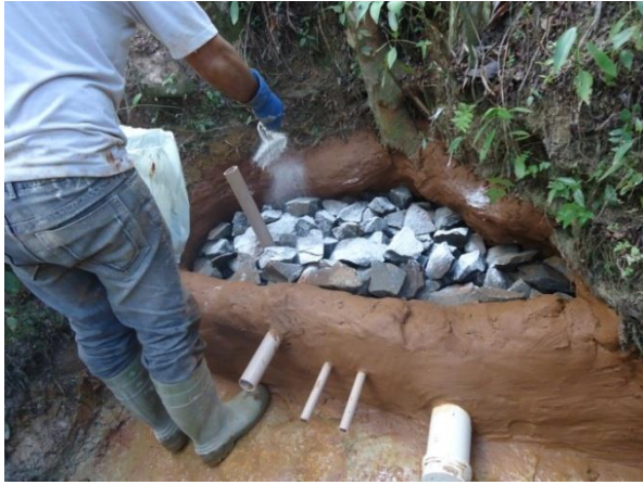
Foto 23 – Cal hidratada sendo esparramado sobre as pedras.
