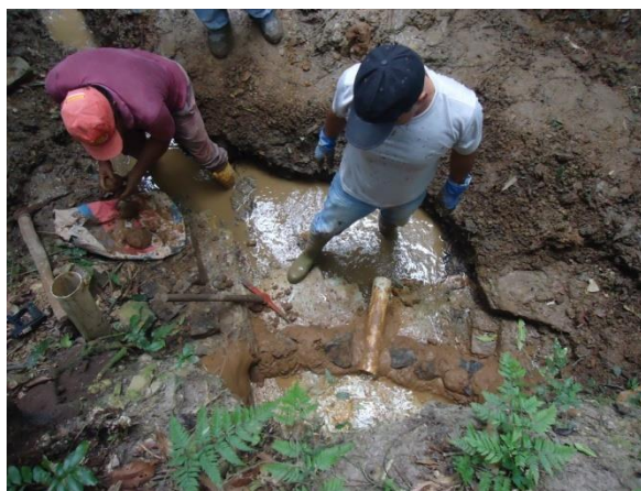
Foto 16 – Construção da barragem, no momento da colocação do cano de esgotamento.
