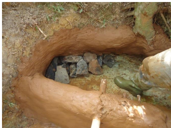
Foto 20 – Início do assentamento das pedras.
