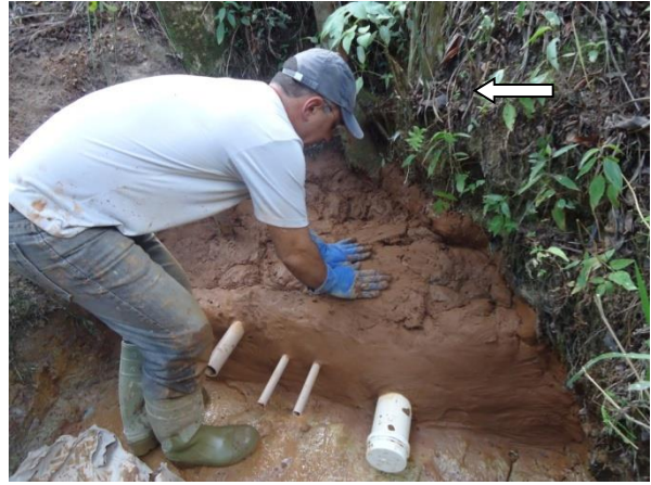
Foto 24 – Fechamento da nascente com a massa de solo-cimento
