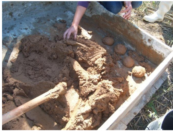
Foto 10 – Massa, após a adição de água.
