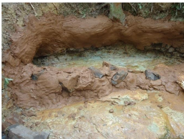
Foto 15 – Aspecto da barragem, observando as pedras unidas pela massa de solo-cimento.
