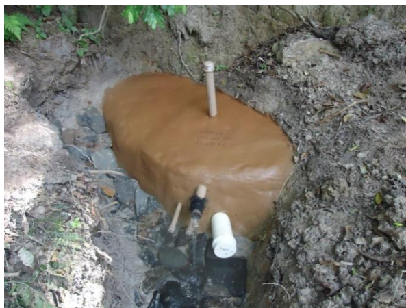
Fotos 35 e 36 – Trabalho de proteção de nascente realizado na propriedade do Sr. Dalmiro Lopes Marçal - Município de Tomazina/PR (aspecto antes e depois)
