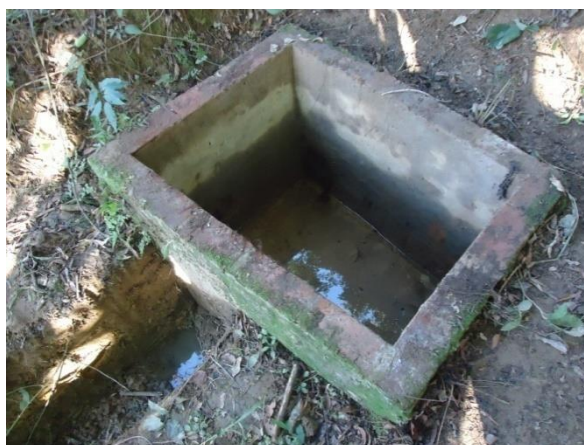
Foto 04 – Nascente com estrutura passível de ser aproveitada.
