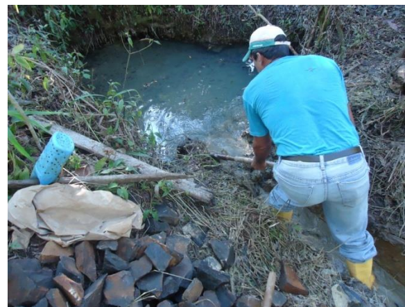
Foto 06 – Abertura da vala de escoamento.
