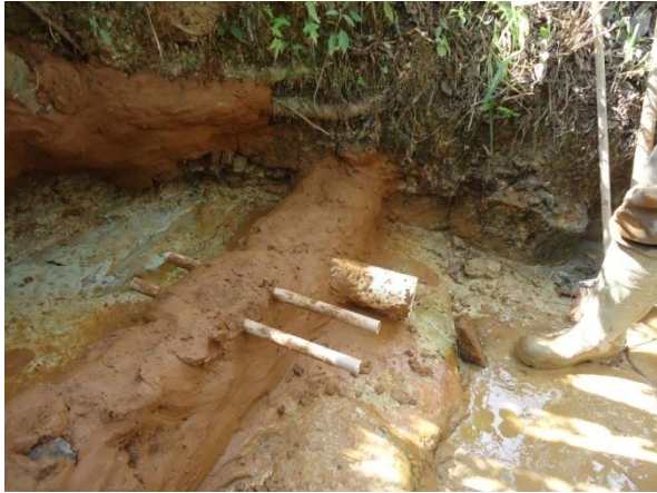
Foto 17 – Assentamento dos canos de abastecimento.
