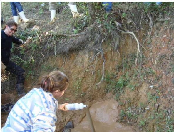
Foto 25 – Hipoclorito de sódio sendo colocado no cano suspiro.
