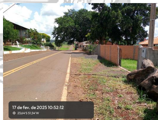
Figura 7 – Construção na faixa de domínio
