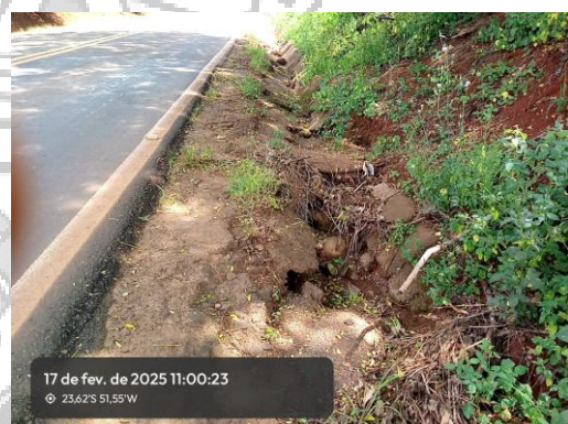
Figura 5 – Drenagem inutilizada
