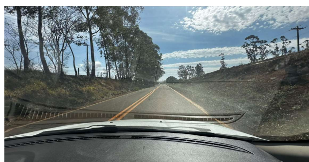
10 - talude a ajustar
