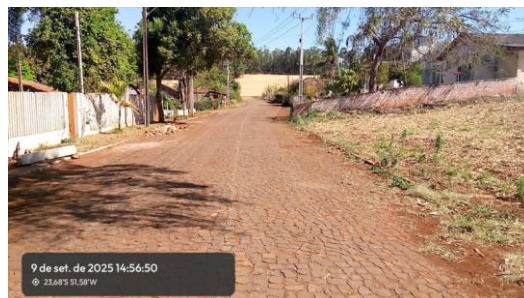
Figura 5 – Pavimentação em pedra
