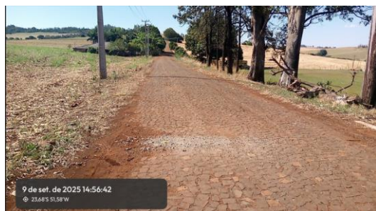
Figura 4 – Pavimentação em pedra
