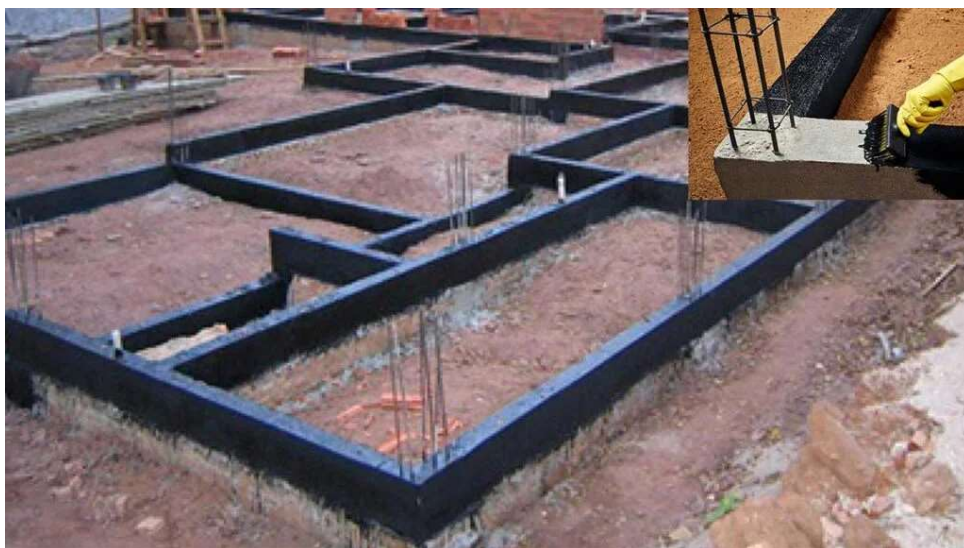
Imagem 8 - Imagem Ilustrativa impermeabilização da viga baldrame.
