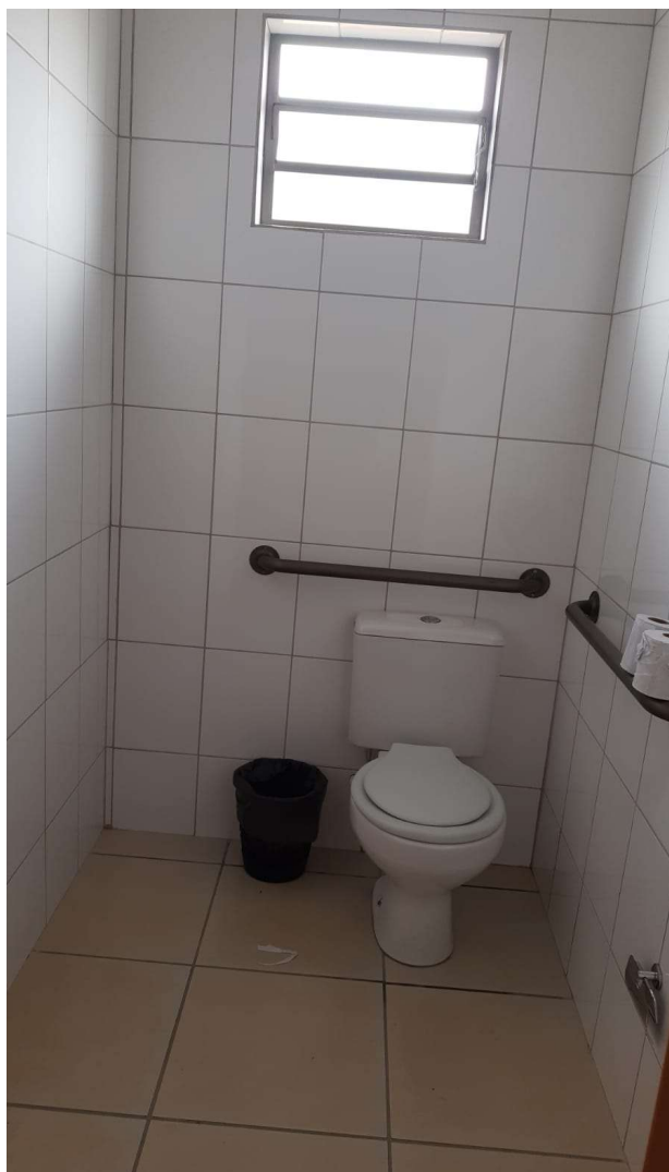
Imagem 6 – Acessórios do banheiro a serem removidos
