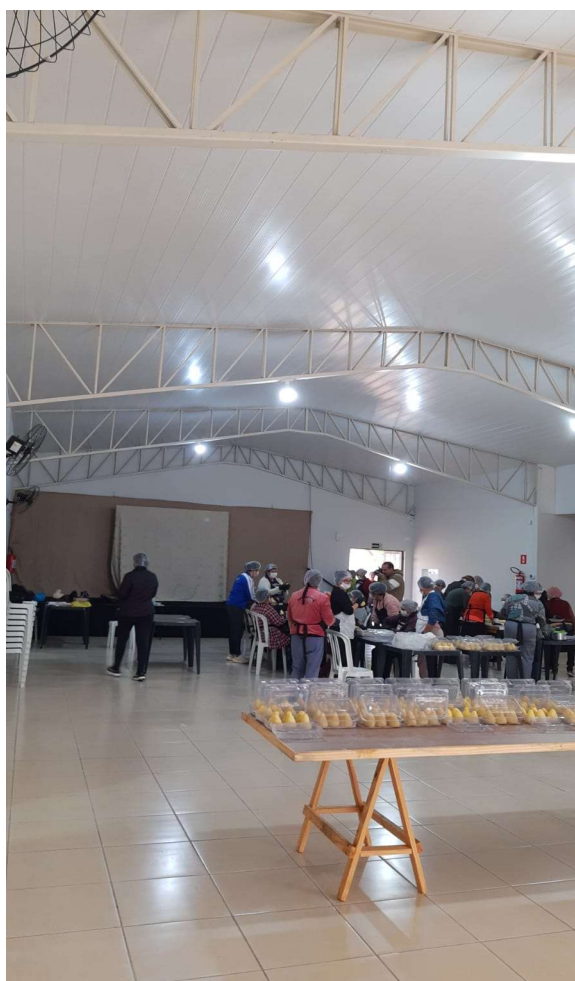
Imagem 4 – Forro e piso a ser removido
