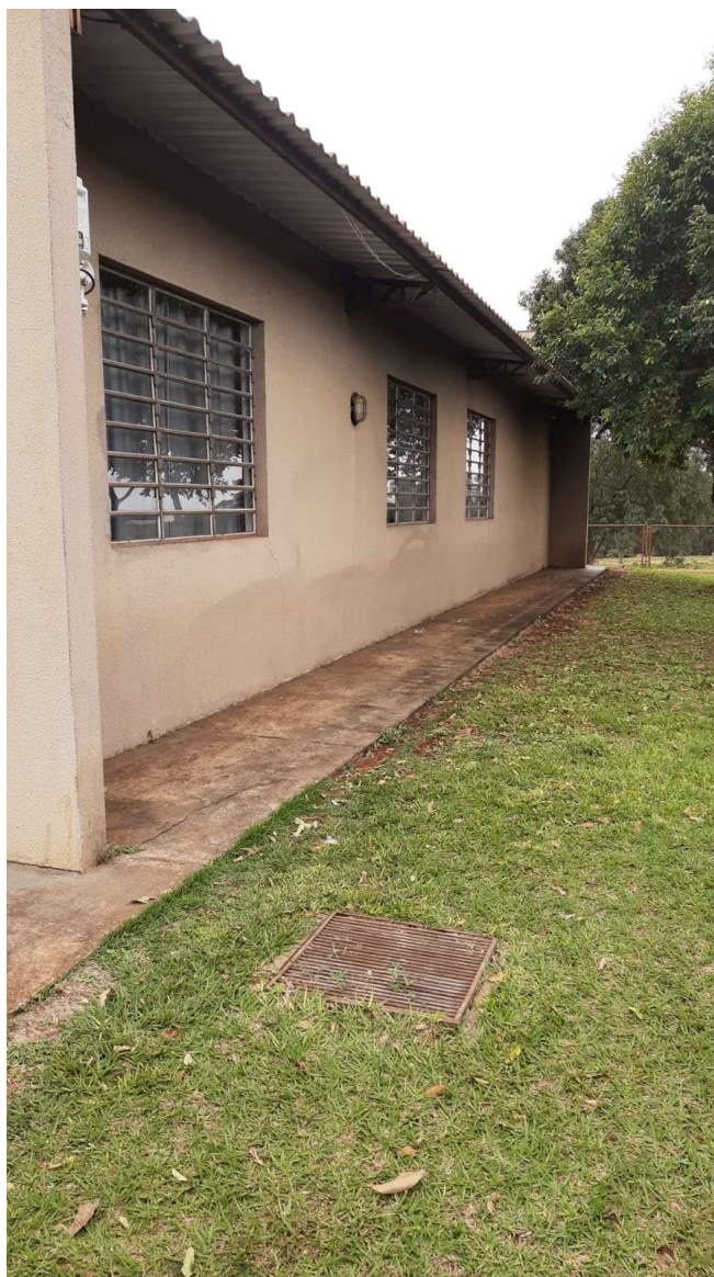
Imagem 5 – Calçada e janelas a serem removidas
