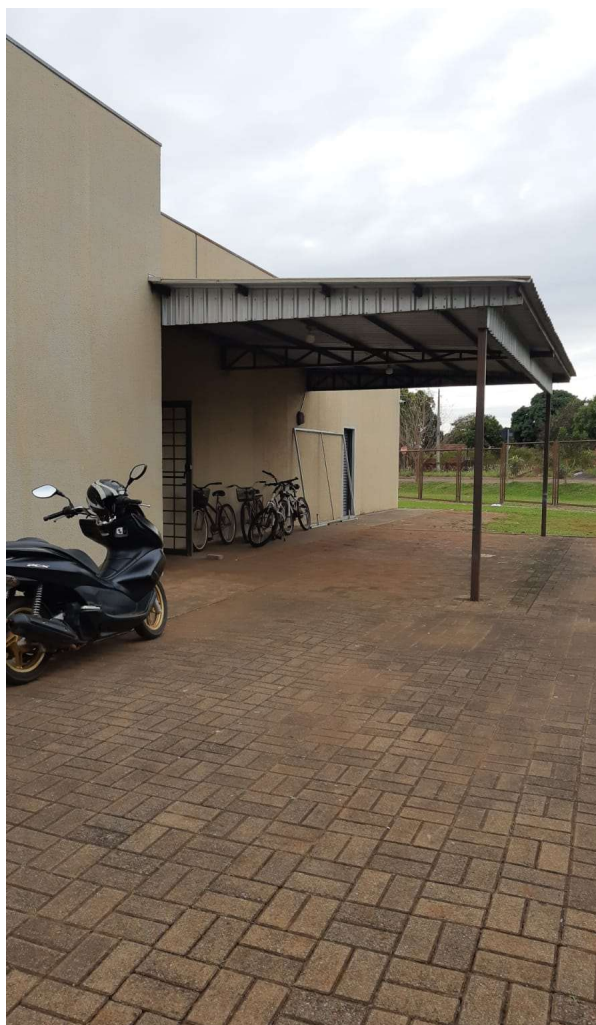
Imagem 7 – Telha e gradis a serem removidos
