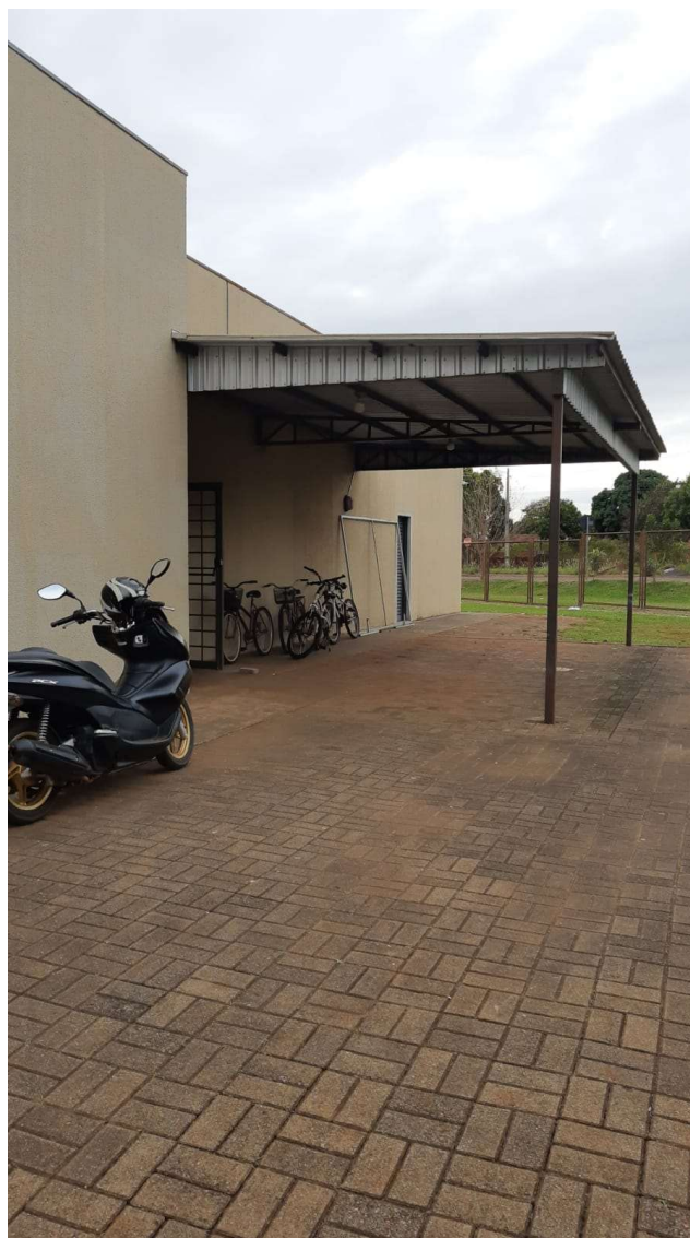
Imagem 3 – Piso paver a ser removido
