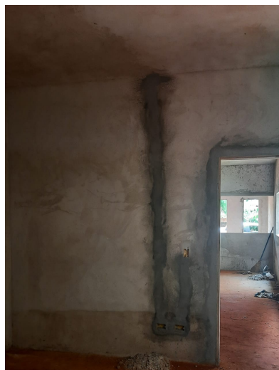
Interno da Sala do Depósito de Medicamentos
