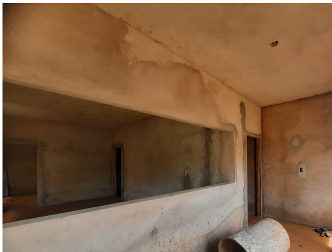
Sala Interna da Recepção
