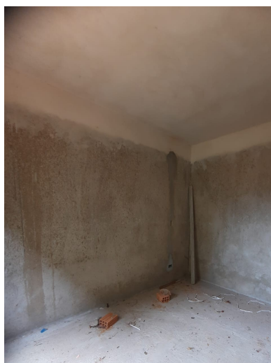
Vista interna da Sala de Endemias
