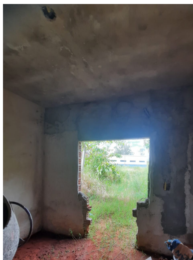
Interna da Sala de Vigilância Sanitária
