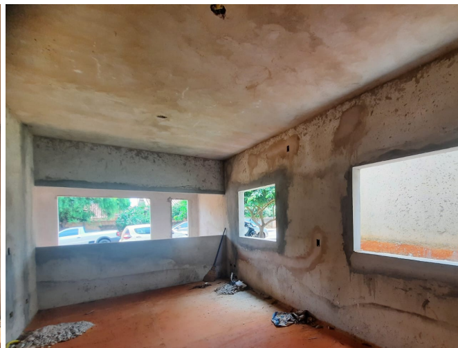
Sala Interna da Farmácia
