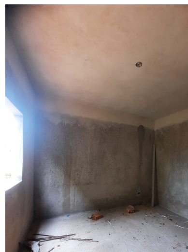
Vista interna da Sala de Endemias
