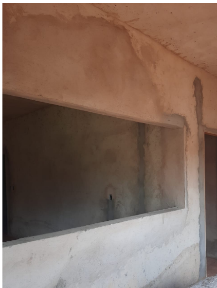
Sala Interna da Recepção
