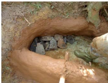
Figura 20 - Início do assentamento das pedras
