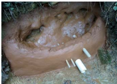
Figura 21 - Aspecto da nascente antes da colocação das pedras
