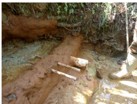
Figura 17 - Assentamento dos canos de abastecimento
