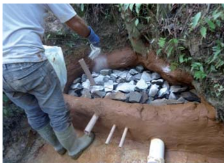
Figura 23 - Cal hidratada sendo esparramado sobre as pedras
