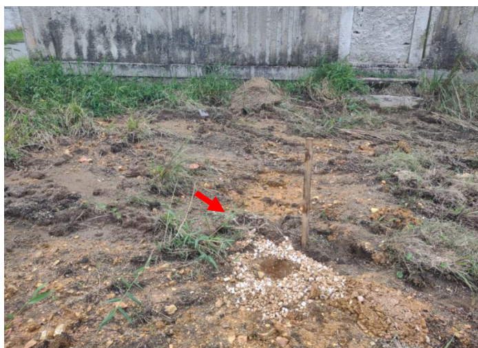
Foto nº03- Detalhe do local do furo da sondagem S-1.
