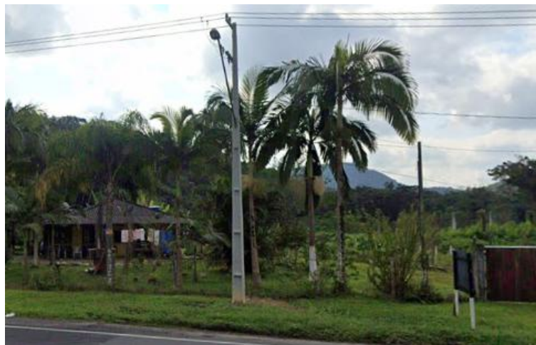
Figura 1 – Exemplo iluminação pública de vapor de sódio 400W
