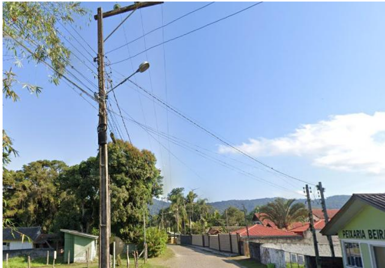
Figura 3 - Exemplo iluminação pública de vapor de mercúrio 400 W
