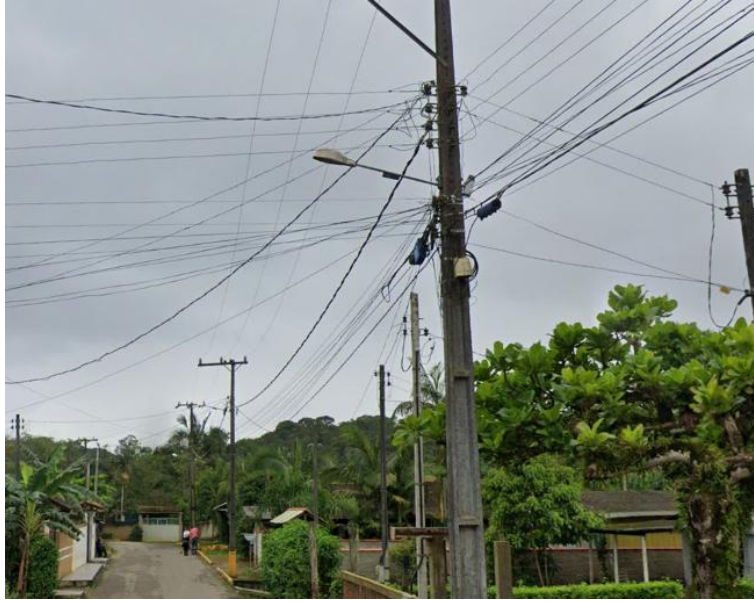
Figura 7 - Exemplo iluminação pública de vapor de mercúrio 125 W
