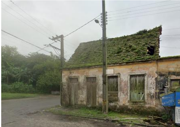
Figura 2 - Exemplo de iluminação pública vapor metálico 400 W
