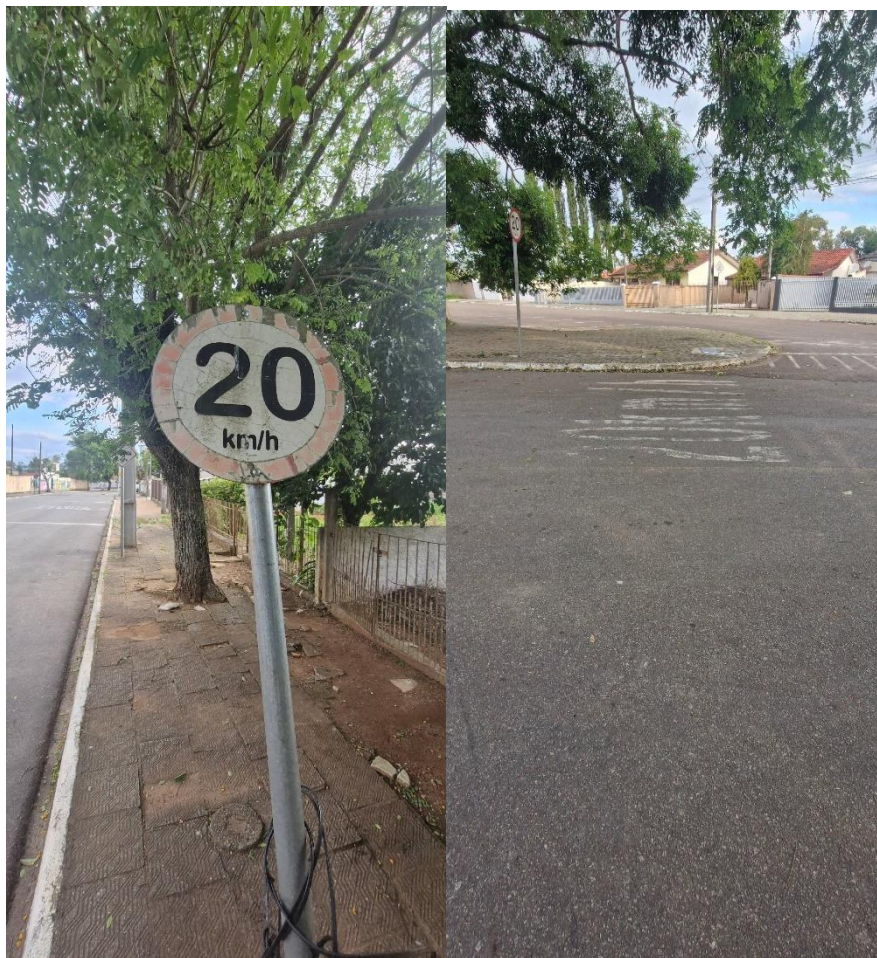
Foto 2 - Placa de limite de velocidade e desgaste de sinalização horizontal.
