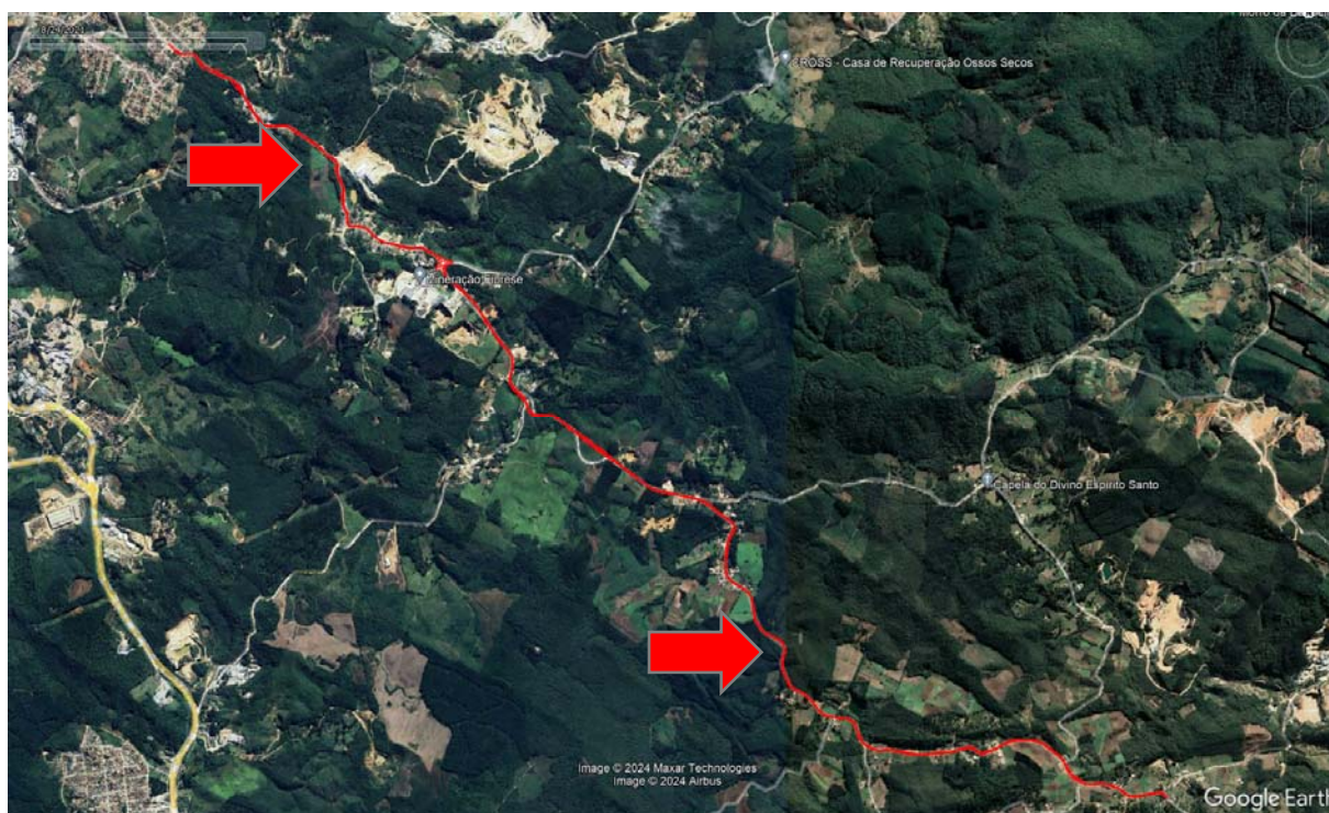
Figura 1 – Trecho da obra de ampliação e da estrada entre os municípios de Colombo e Rio Branco do Sul.
