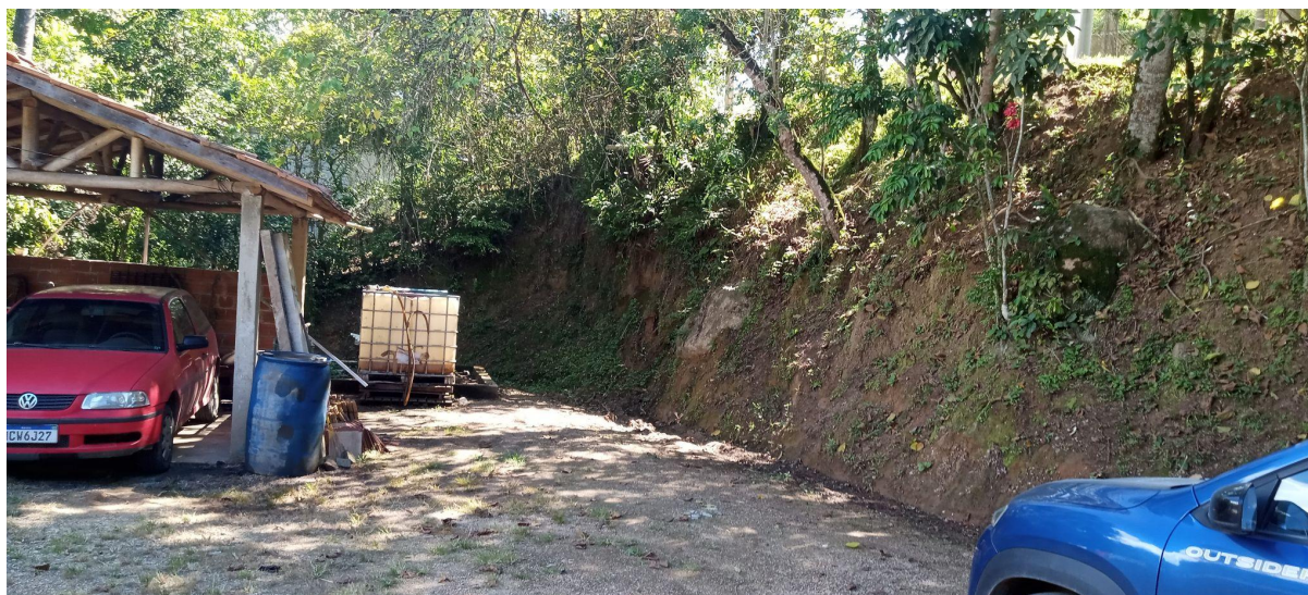
Figura 1 – Imagem da frente do imóvel avaliado
