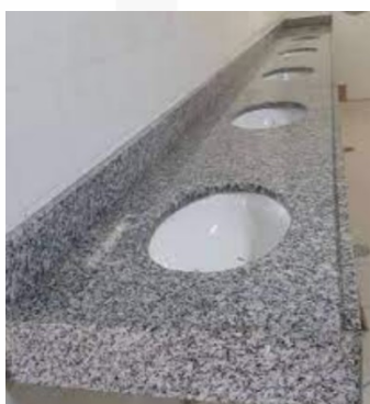
Figura 12: Bancada em granito cinza andorinha com cuba de embutir Fonte: Imagem da Internet, 2025.
