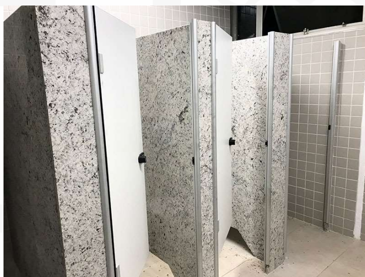
Figura 22: Modelo genérico das divisórias em granito.
