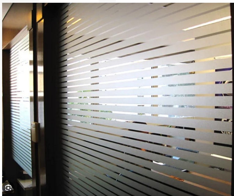
Figura 05: Detalhe da plotagem junto às divisórias de vidro.
