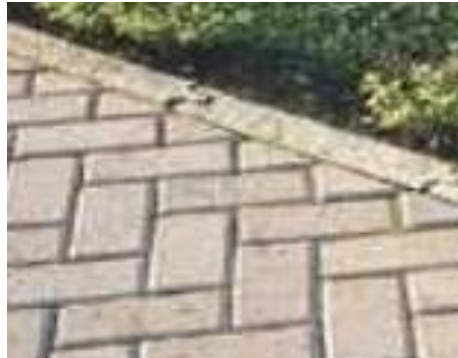
Figura: Guia de Concreto para contenção lateral
