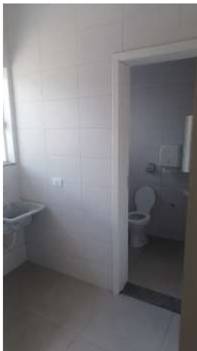
Imagem da área do vestiário/lavanderia
