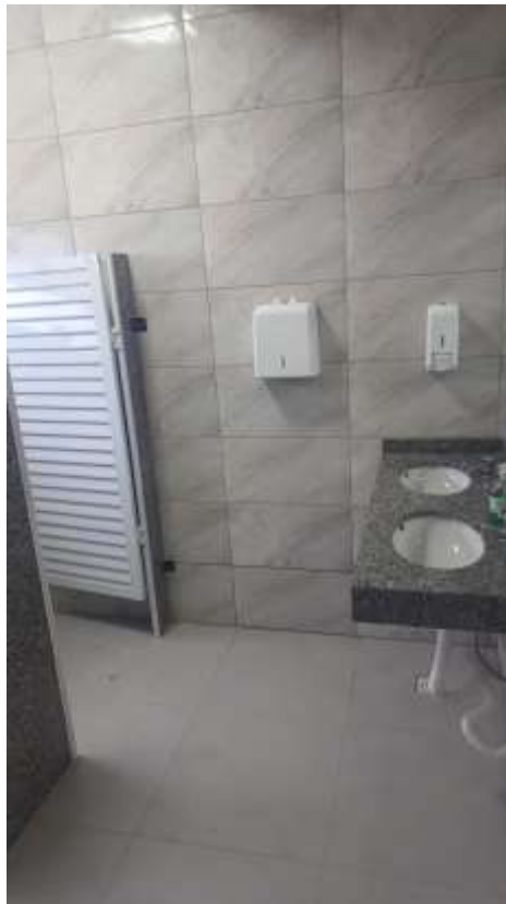
Imagem da área do banheiro
