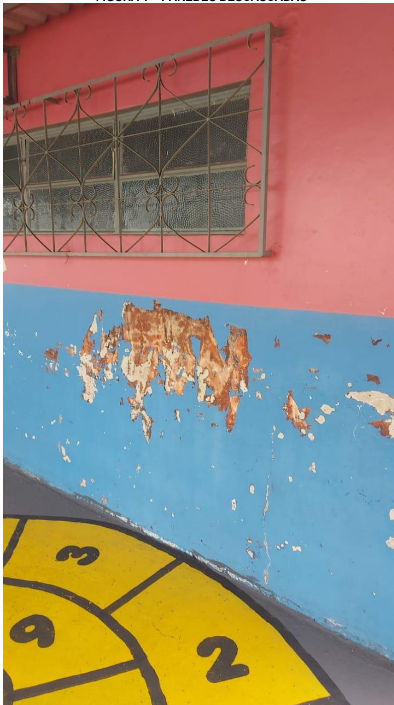
FIGURA 1 – PAREDES DESCASCADAS
