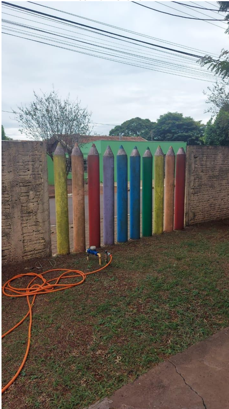
FIGURA 6 – MURO DO CMEI
