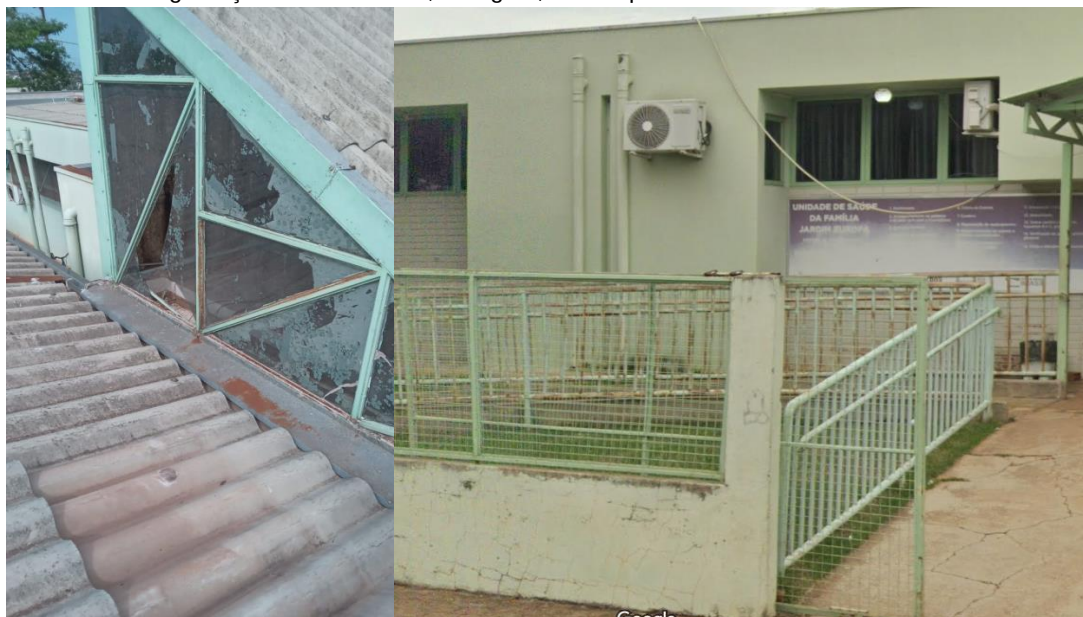
Figura 3: Vidros e estrutura metálica do telhado da circulação central e ferragens e estrutura frontal. Identifica-se degradação das estruturas, ferrugem, vidros quebrados e rachaduras na alvenaria.
