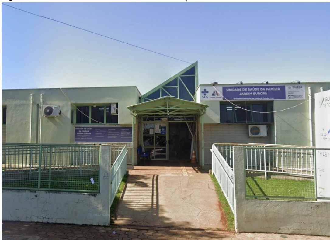
Figura 1: Fachada Frontal – Estrutura metálica e circulação frontal
