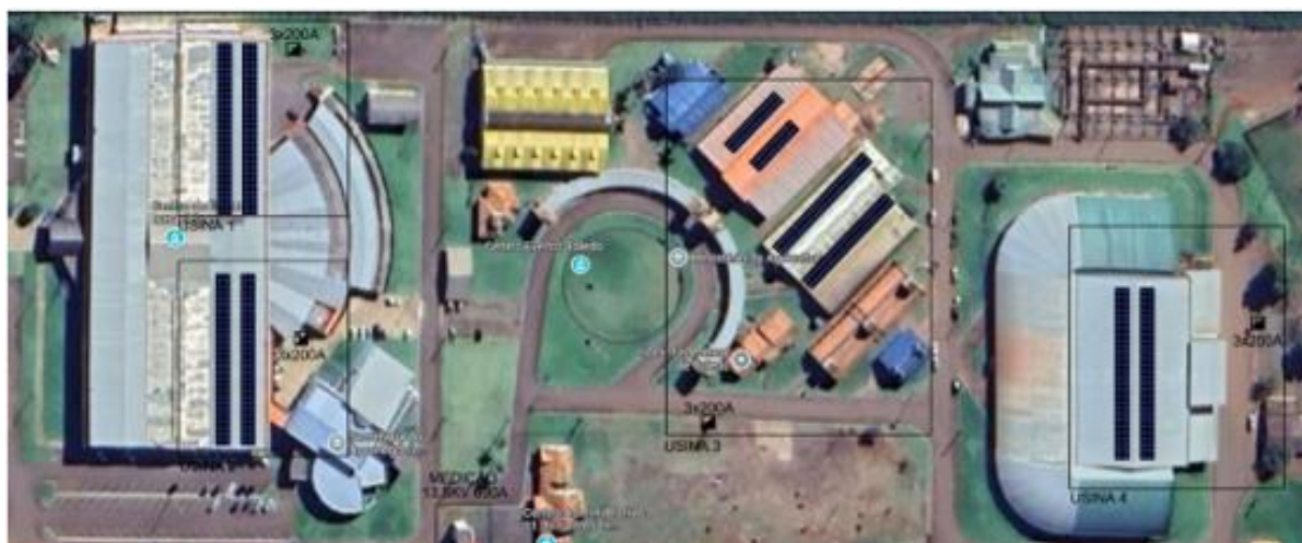
FIGURA 47: Localização das 4 unidades geradoras de 75 kW.
