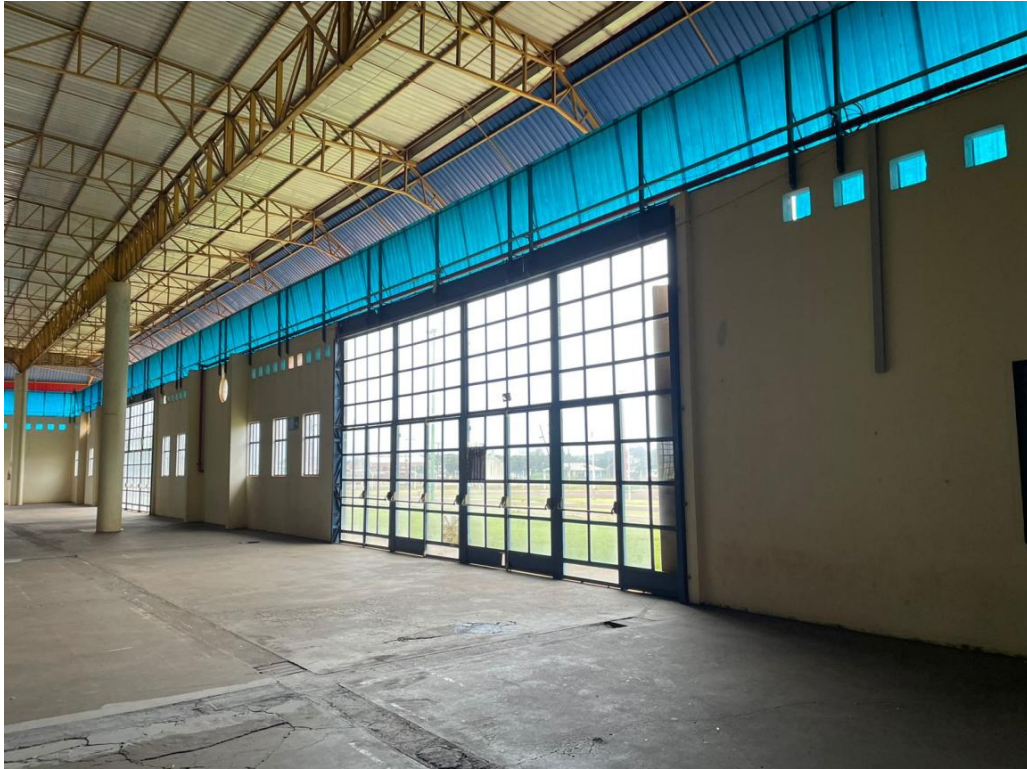
FIGURA 26: Portões de acesso – Foto interna do Centro de Exposições. Fonte: Acervo próprio.
