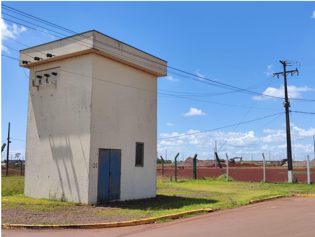
FIGURA 32: Entrada de Energia Alta Tensão. Fonte: Acervo próprio.
