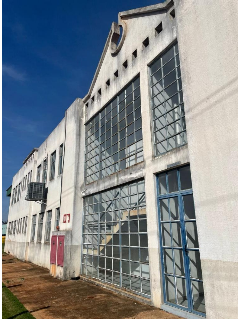
FIGURA 28: Fachada lateral – Vista dos camarins. Fonte: Acervo próprio.
