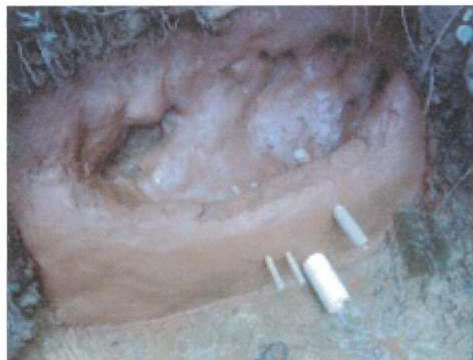
Figura 21 - Aspecto da nascente antes da colocação das pedras
