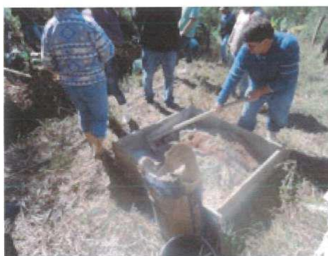
Figura 9 - Mistura de terra com cimento
