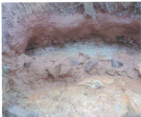
Figura 15 - Aspecto da barragem, observando-se as pedras unidas pela massa de solo-cimento
