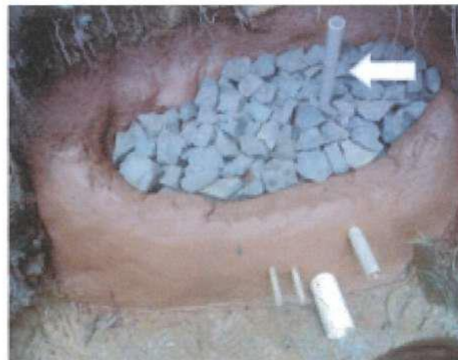
Figura 22 - Nascente preenchida com pedras. Observe o assentamento do cano suspiro (seta)
