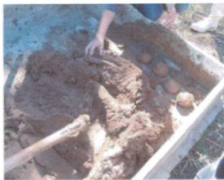
Figura 10 - Massa após a adição de água
