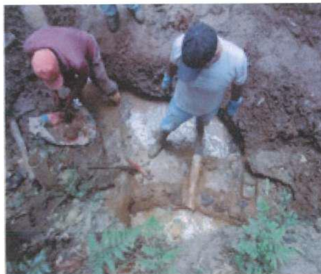
Figura 16 - Construção da barragem no momento da colocação do cano de esgotamento
