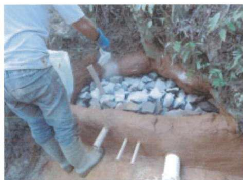
Figura 23 - Cal hidratada sendo esparramado sobre as pedras
