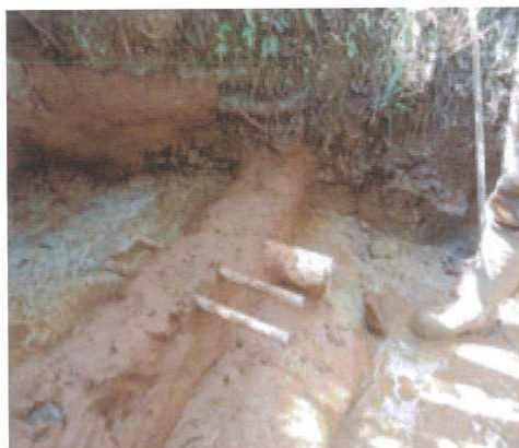
Figura 17 - Assentamento dos canos de abastecimento
