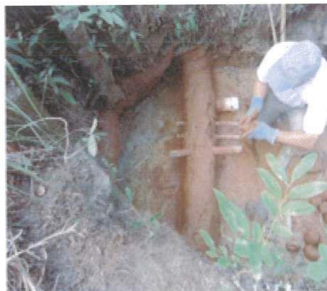
Figura 18 - Assentamento do cano ladrão
