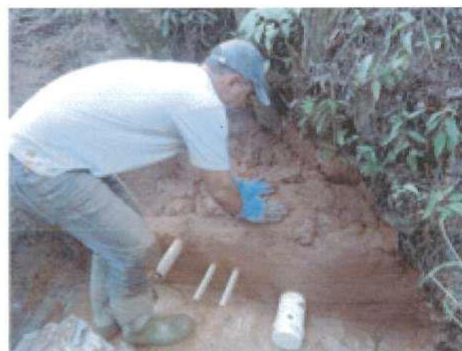
Figura 24 - Fechamento da nascente com a massa de solo-cimento
