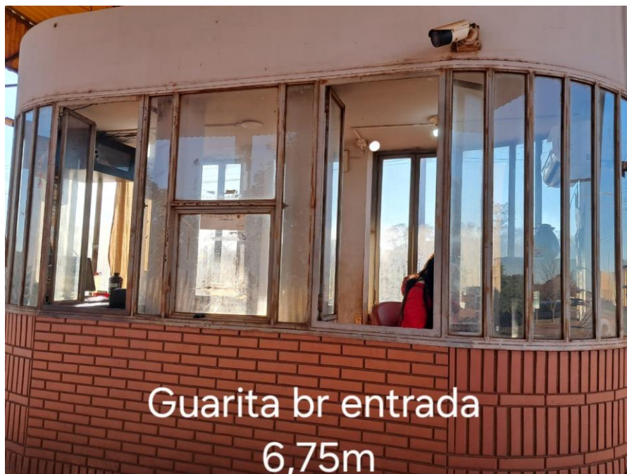
Figura 12 - Guarita de entrada ao porto (trânsito nacional)
