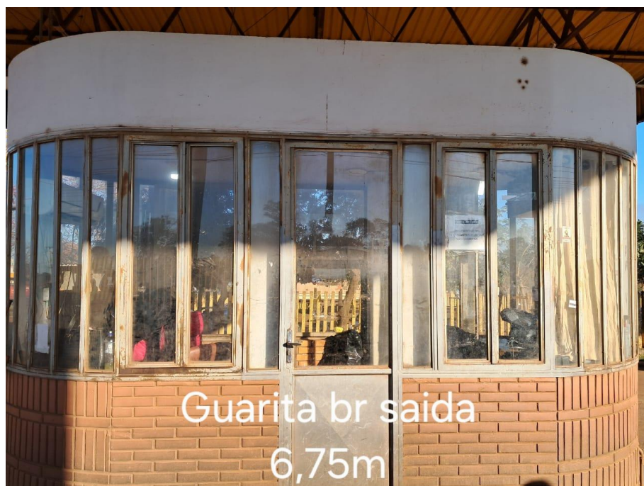
Figura 13 - Guarita de saída do porto (trânsito nacional)
