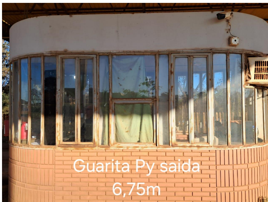
Figura 15 - Guarita de saída do porto (trânsito internacional)
