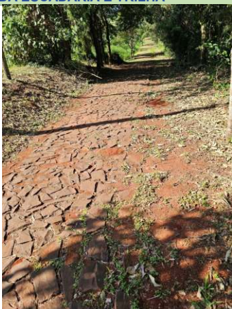
FOTO 5 - VIA DA ESCADARIA E TRILHA
