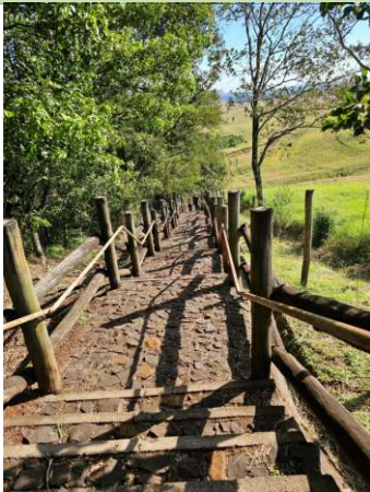
FOTO 3 - VIA DA ESCADARIA E TRILHA
