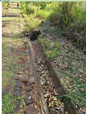
FOTO 6 - VIA DA ESCADARIA E TRILHA
