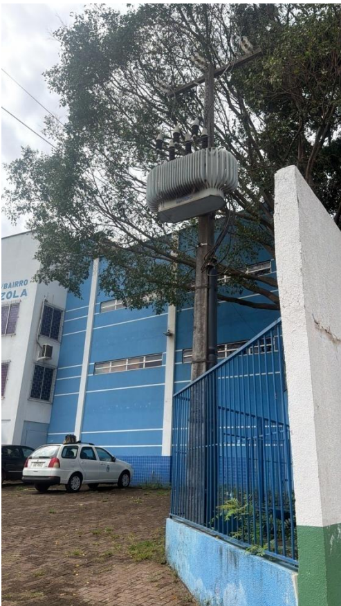
Figura 4 – Vegetação no entorno da subestação
