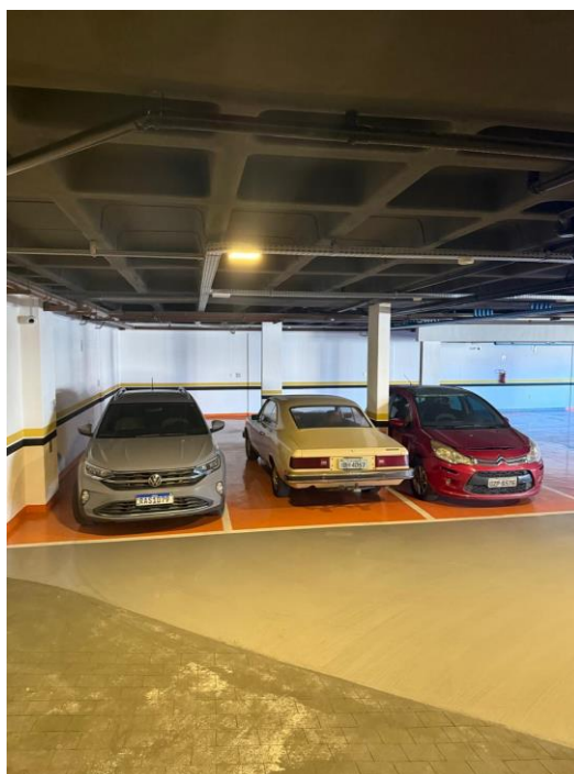
Figura 5.1 - Paredes internas com faixas de sinalização intermediárias, teto acabado laje nervurada, piso com pintura epóxi com demarcações de vagas e iluminação com sensores.
