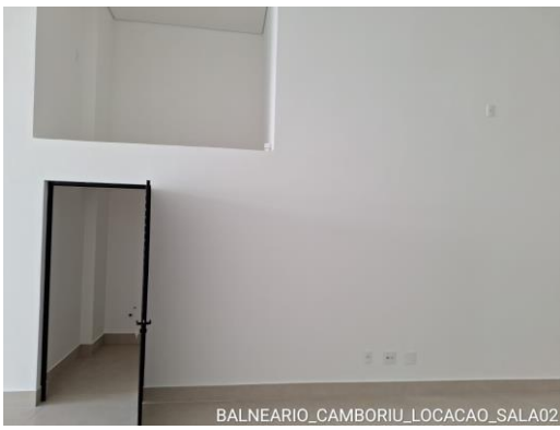
Figura 3.8 – Ponto de esgoto e tomadas no mezanino
