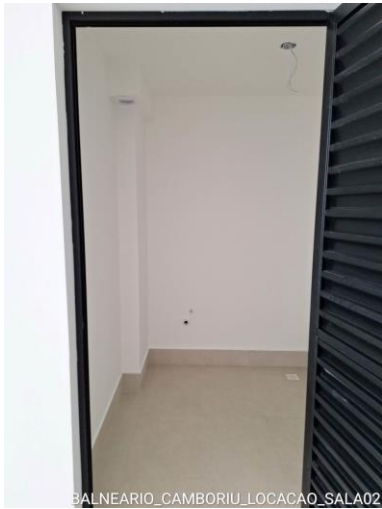
Figura 3.9 – Exaustor, fiação para iluminação, pontos de água e esgoto e ralo no banheiro
