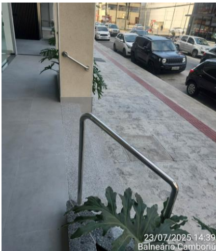
Figura 1.5 – Escada de acesso
