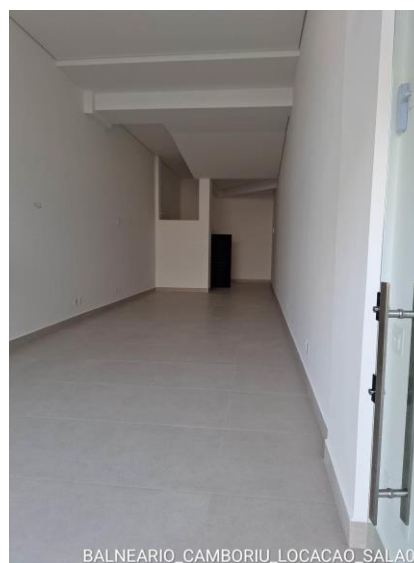
Figura 4.2 – Paredes internas em alvenaria com pintura na cor branca, teto com gesso acartonado, piso cerâmico 90x90 e rodapé de mesmo material
