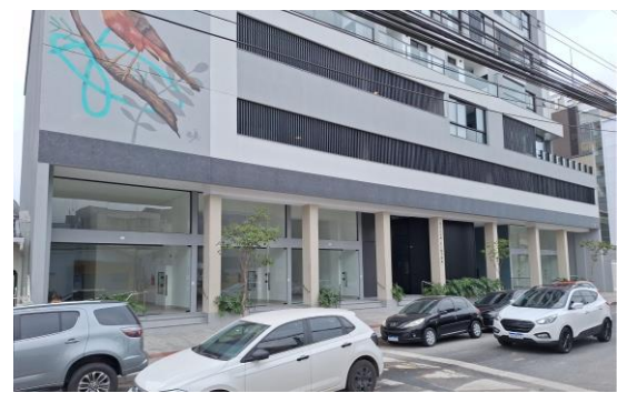
Figura 1.1 – Fachada frontal do imóvel
