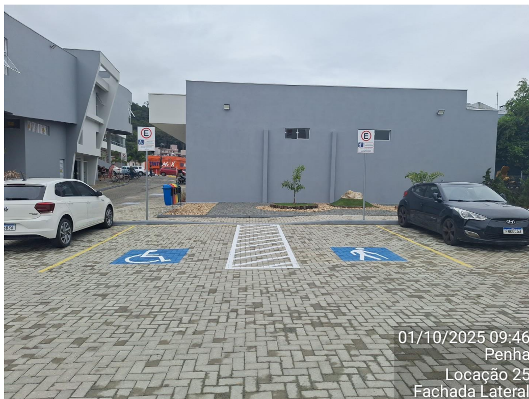
Imagem 5: Local de instalação das placas de estacionamento.
