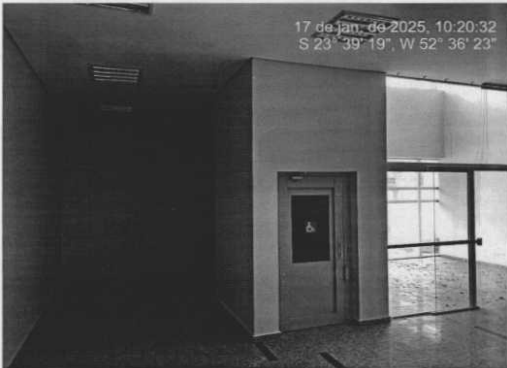
Imagem 08 – Plataforma elevatória não consta no projeto aprovado.
