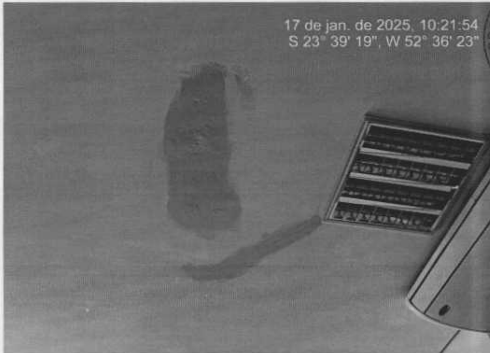
Imagem 04 – Forro com humidade no pavimento térreo.
