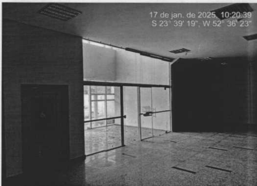
Imagem 03 – Área interna – Acesso edificação/ Plataforma elevatória PcD.
