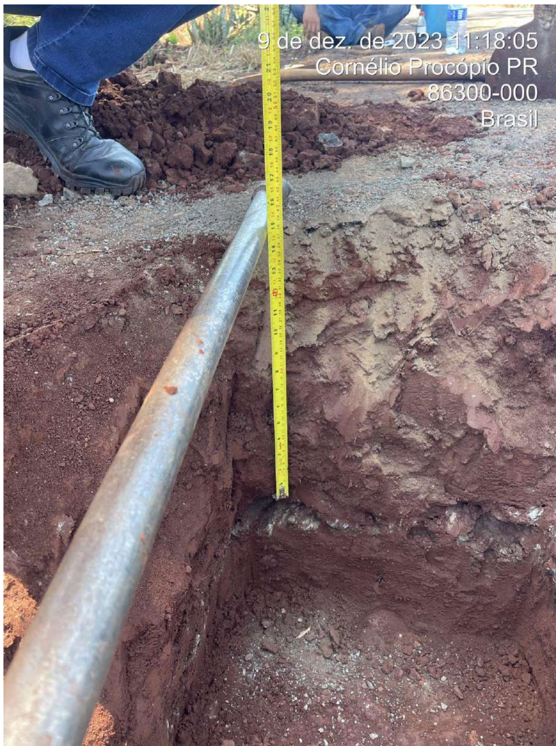
Figura 6. Medição da espessura da base. Fonte: os Autores.
