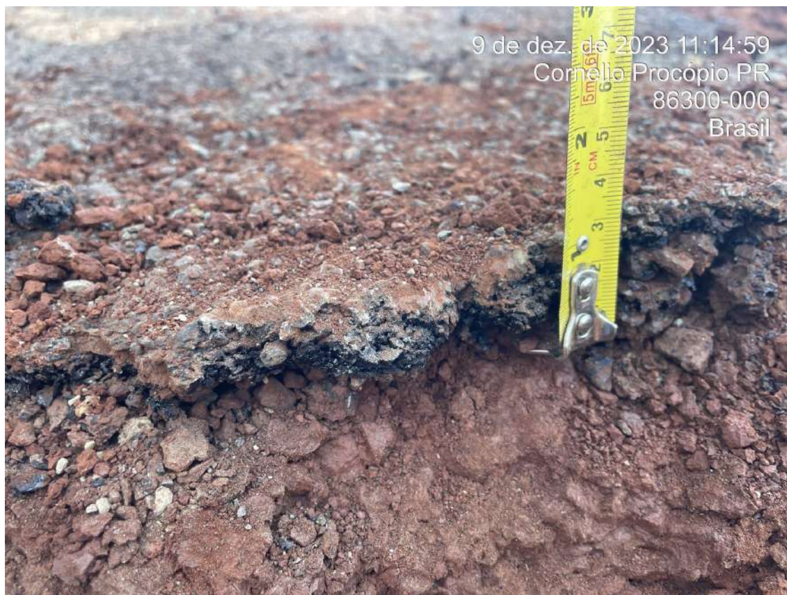
Figura 4. Medição da espessura do revestimento existente. Fonte: os Autores.
