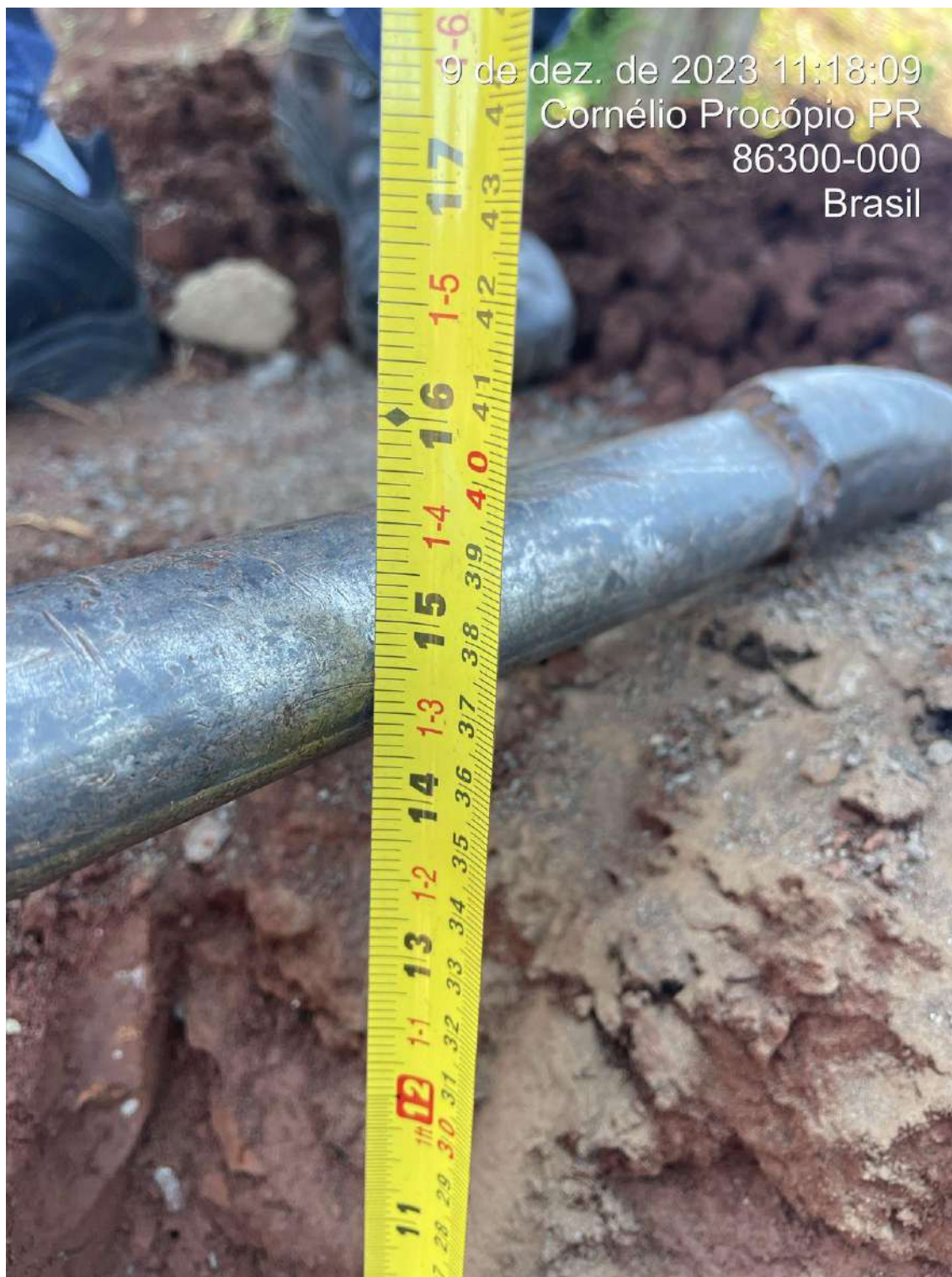
Figura 5. Medição da espessura da base. Fonte: os autores.
