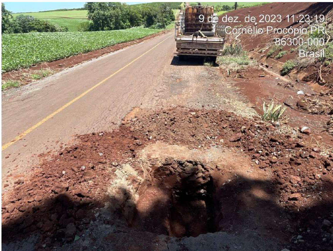
Figura 3. Poço de Inspeção. Fonte: os Autores.
