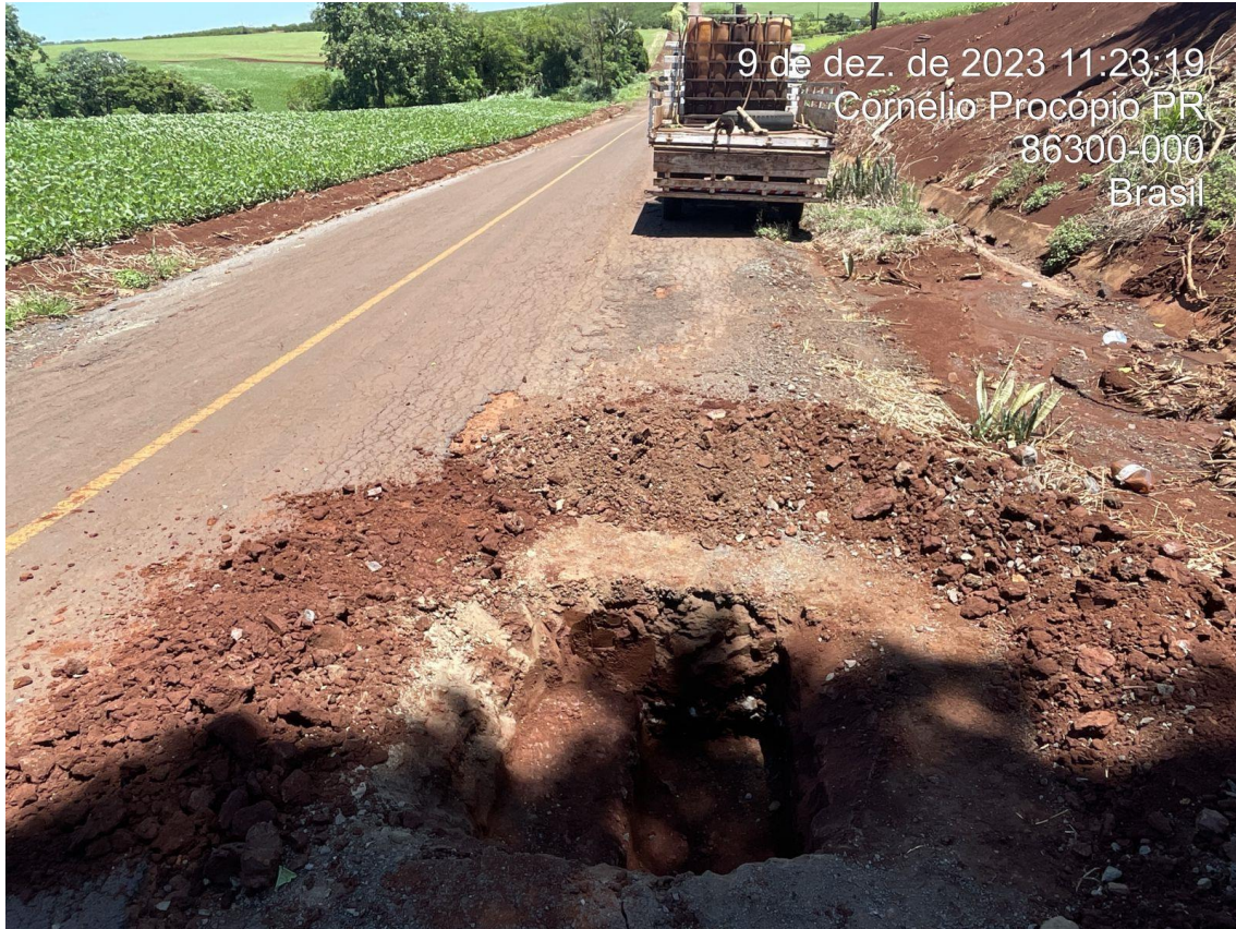
Figura 3. Poço de Inspeção. Fonte: os Autores.
