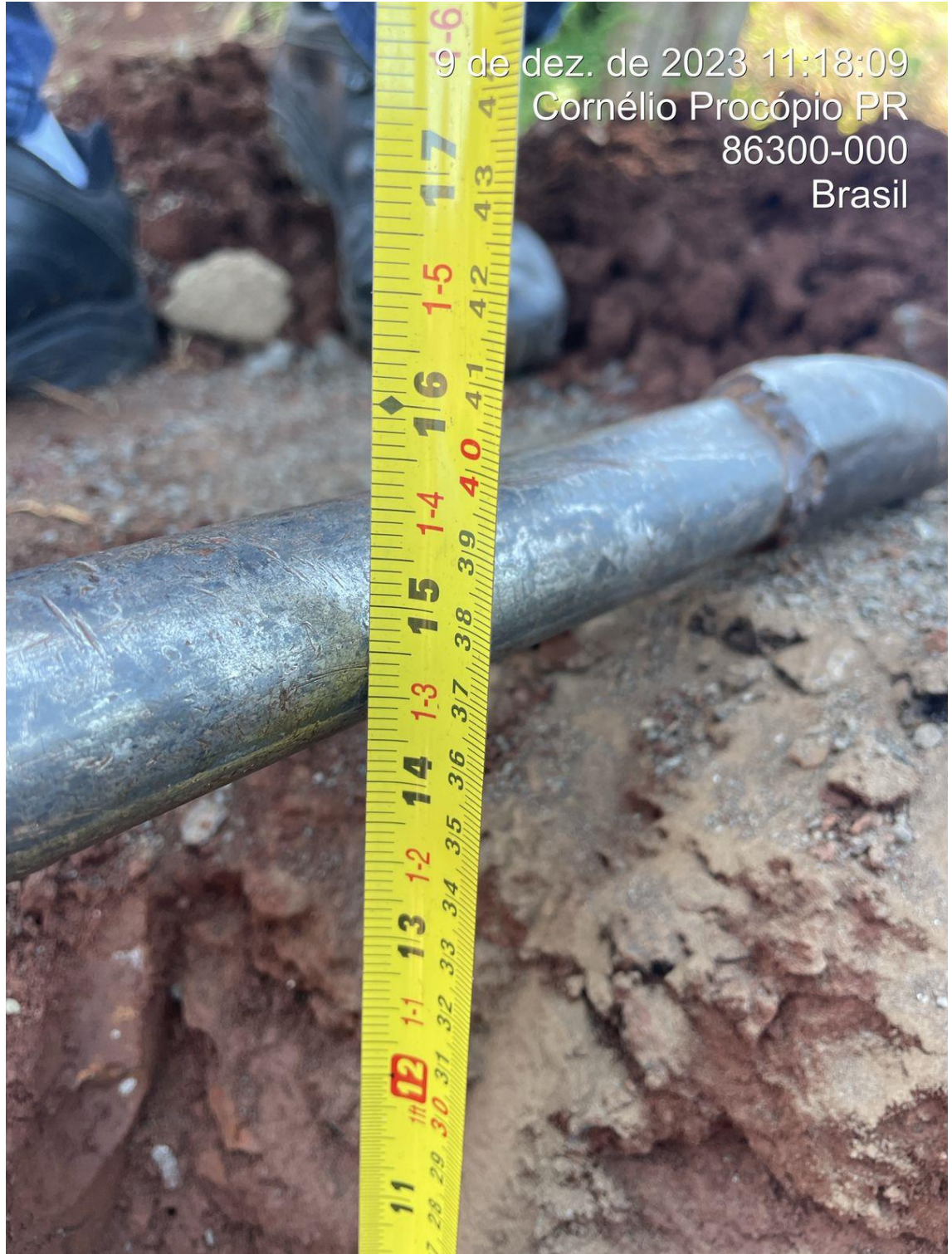
Figura 5. Medição da espessura da base. Fonte: os autores.
