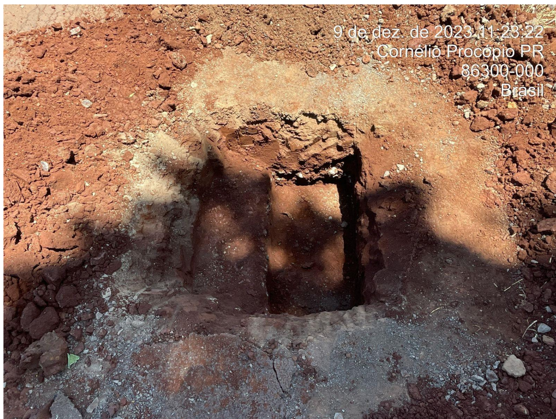
Figura 8. Vista geral do poço de inspeção. Fonte: os Autores.
