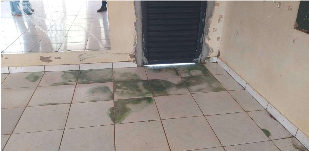
Imagem 07 – Sala de oficina de balé, substituição do piso cerâmico;
