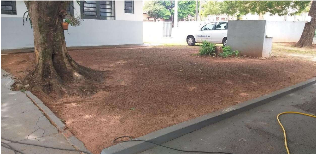
Imagem 05 – Área onde será realizado o piso cimentado rústico para pátio externo;
