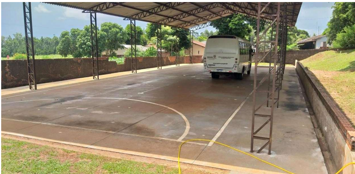
Imagem 08 – Quadra coberta, será realizada a pintura do piso da mesma;
