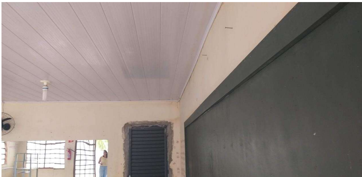
Imagem 11- Substituição do forro e pintura interna na sala de oficina de balé ANEXO II.1 – ESTUDO TÉCNICO PRELIMINAR
