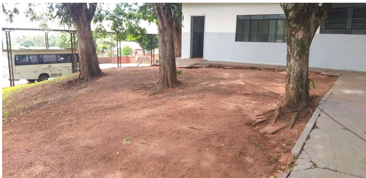
Imagem 04 – Área onde será realizado o piso cimentado rústico para pátio externo;
