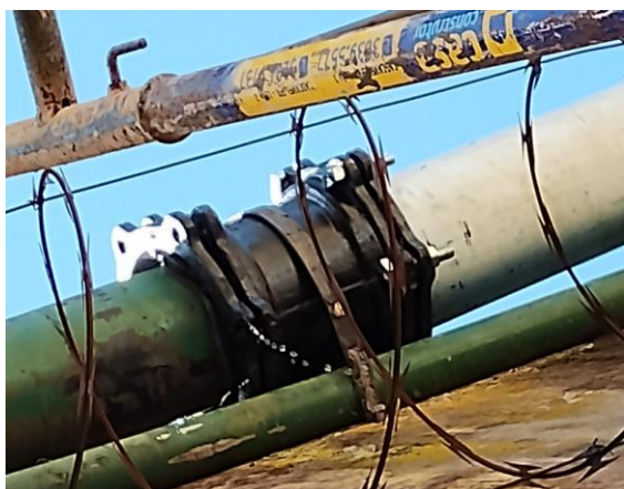
FOTO 17 – TUBULAÇÃO APÓS CONCERTO
