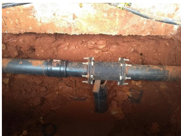
FOTO 10 – TUBULAÇÃO APÓS CONCERTO (DEPOIS)
