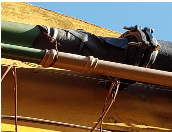
FOTO 5 – APÓS MANUTENÇÃO DE TUBULAÇÃO
