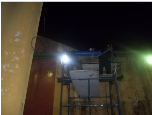
FOTO 3 – MANUTENÇÃO DE TUBULAÇÃO
