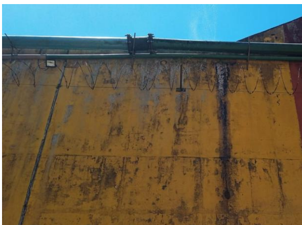
FOTO 15 – TUBULAÇÃO APÓS CONCERTO
