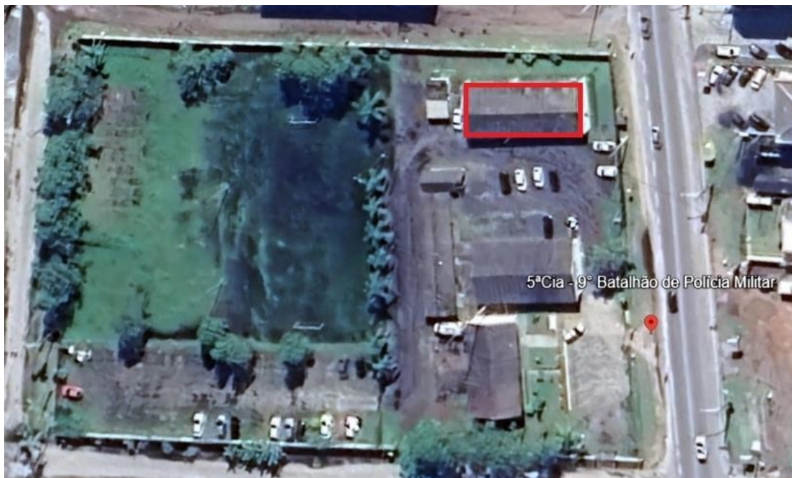
Telhado alojamento, academia e banheiro
