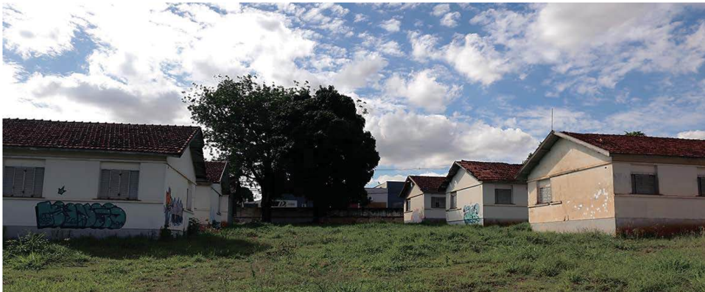
Moradores reclamam há anos do estado de abandono dos imóveis, marcado pelo acúmulo de lixo, mato alto e presença frequente de pessoas em situação de rua e usuários de drogas
