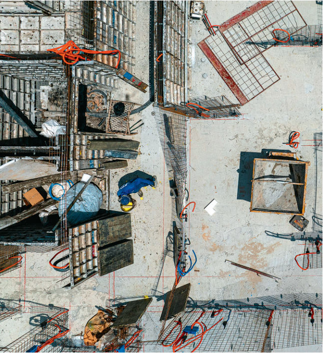
Imóvel no Ipiranga, em São Paulo, durante fase de construção Danilo Verpa - 14.mar.24/Folhapress
