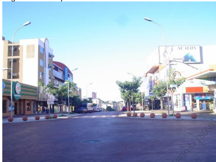
Figura 4 – Exemplo de rede subterrânea totalmente enterrada.
