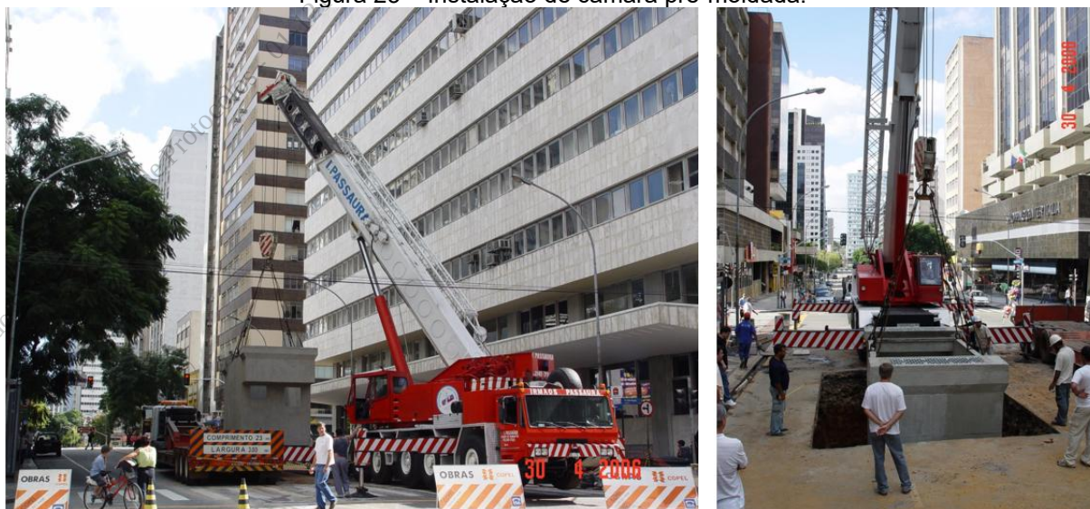
Figura 23 – Instalação de câmara pré-moldada.
