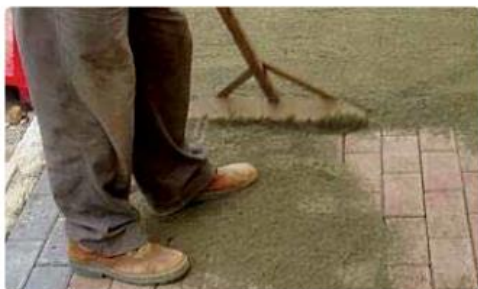
Selagem do pavimento
