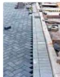
Ajuste e arremate dos blocos
