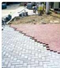
Ajuste e arremate dos blocos
