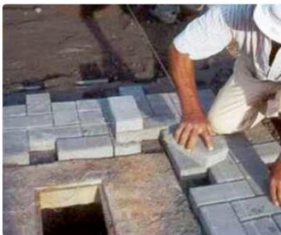
Acabamento junto ao confinamento interno
