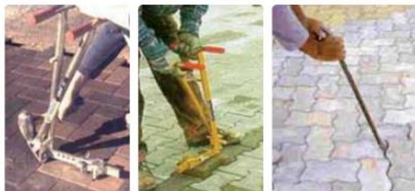
Retirada dos blocos danificados
