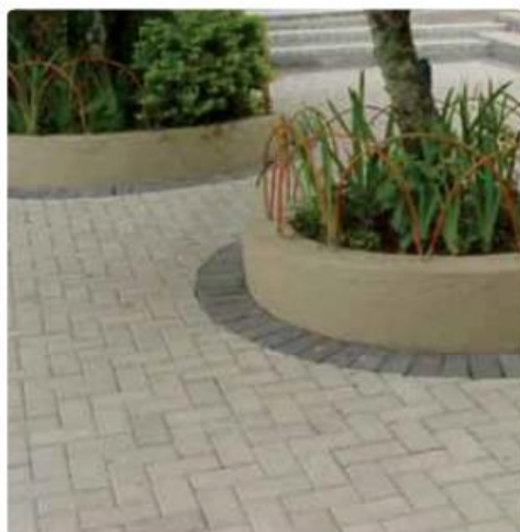
Acabamento junto ao confinamento interno
