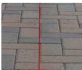
Alinhamento e juntas corretas
