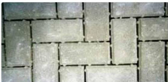
Assentamento de blocos com separadores
