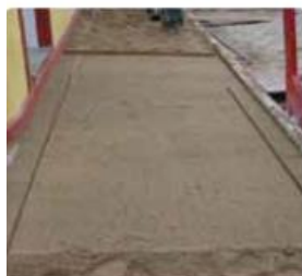
Camada de assentamento
