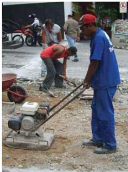
Compactação do subleito
