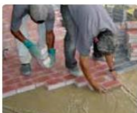
Frente de serviço organizada para assentamento dos blocos
