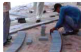
Assentamento da primeira fiada
