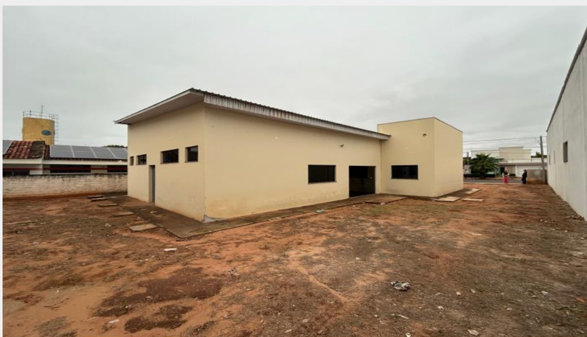
Imagem 2 – Calçada a demolir
