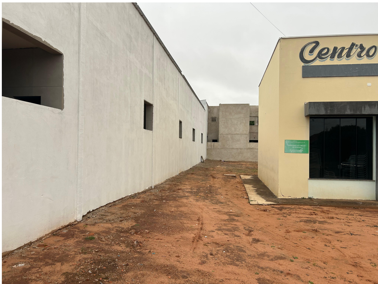
Imagem 3 – Parte do muro a demolir
