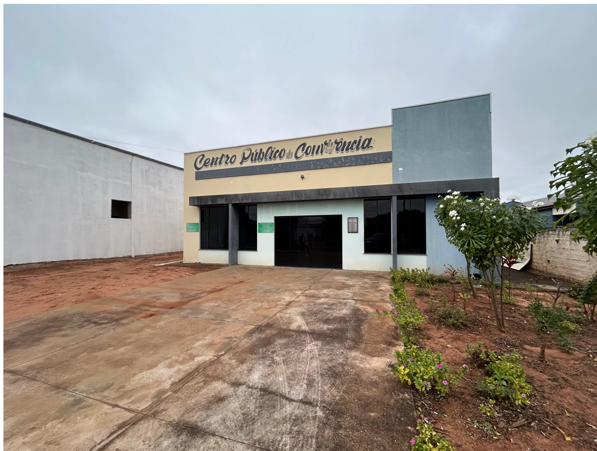
Imagem 1 – Calçada a demolir
