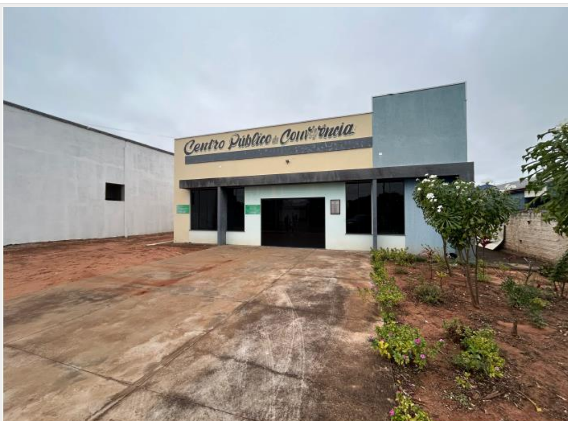
Imagem 1 – Calçada a demolir
