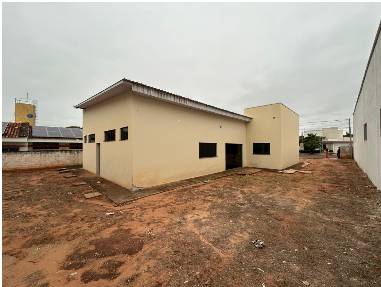
Imagem 2 – Calçada a demolir
