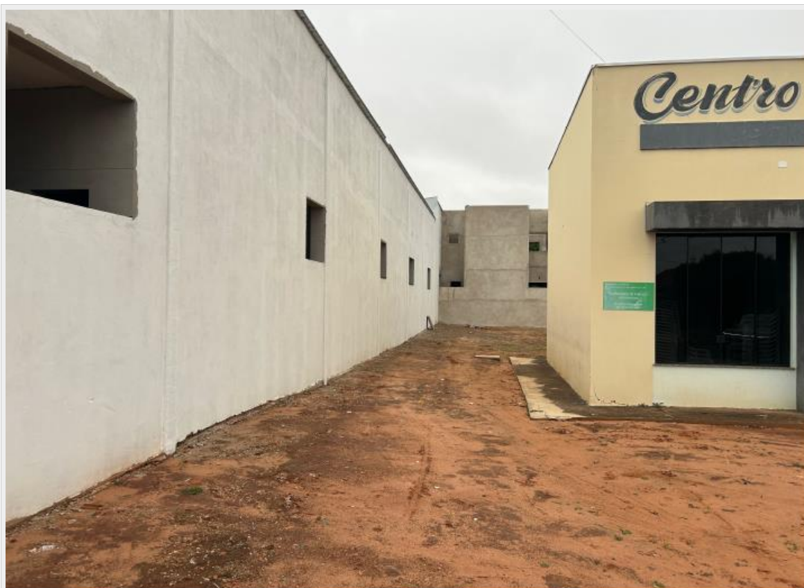
Imagem 3 – Parte do muro a demolir
