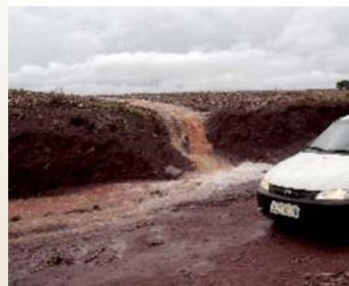
Figura 5 - Enxurrada destruindo estrada
