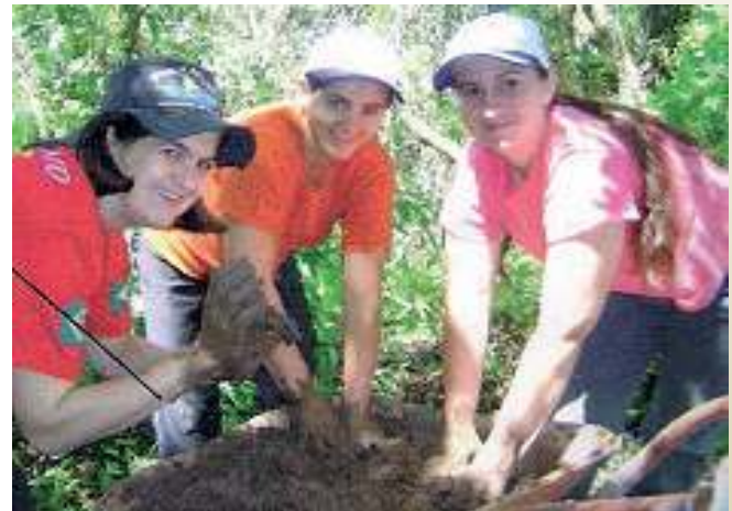
Figura 22 - Mistura do cimento com o solo
