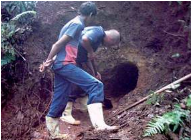
Figuras 20 - Escavações para liberação da nascente
