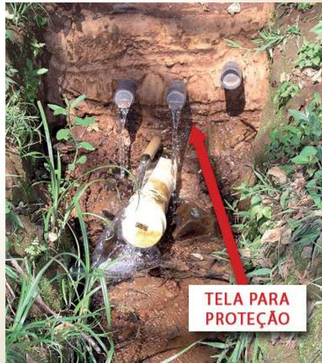
Figura 29 - Nascente pronta com telas de proteção
