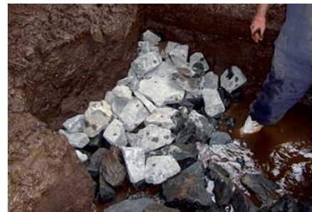
Figura 27 Enchimento da nascente com pedras
