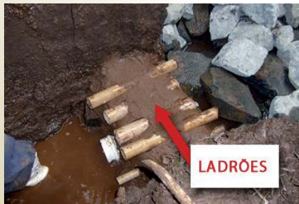
Figura 26 Instalação de canos "ladrões"
