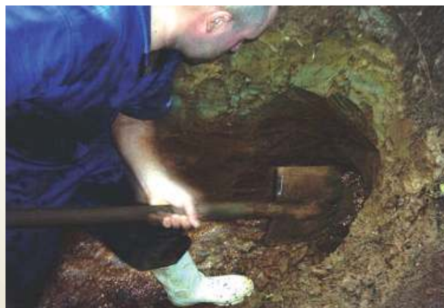
Figuras 19 - Escavações para liberação da nascente
