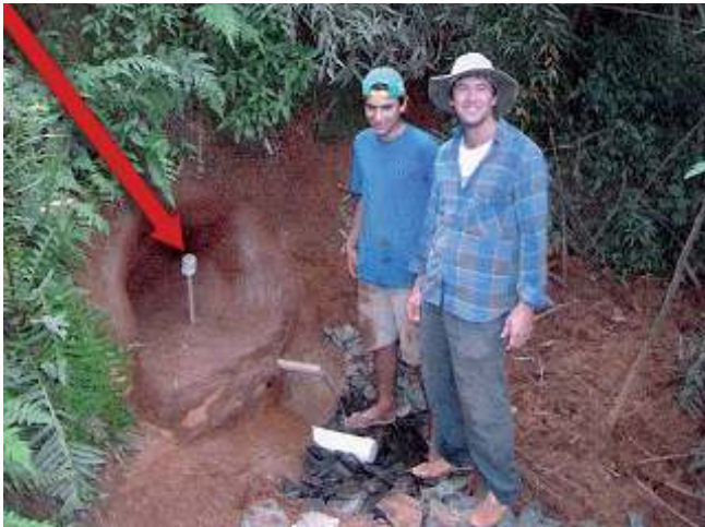
Figura 28 - Nascente pronta com cano de desinfecção instalado.
