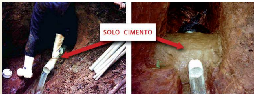
Figura 23 e 24 - Assentamento do cano de 100 mm com solo-cimento
