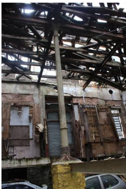
Foto 27: Compensados fixados na fachada e madeiramento da cobertura. Fonte: BBC Engenharia e Arquitetura Ltda.
