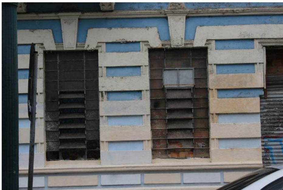
Foto 23: Pintura da fachada externa com descolamentos generalizados e em alguns pontos mais acentuado. Fonte: BBC Engenharia e Arquitetura Ltda.
