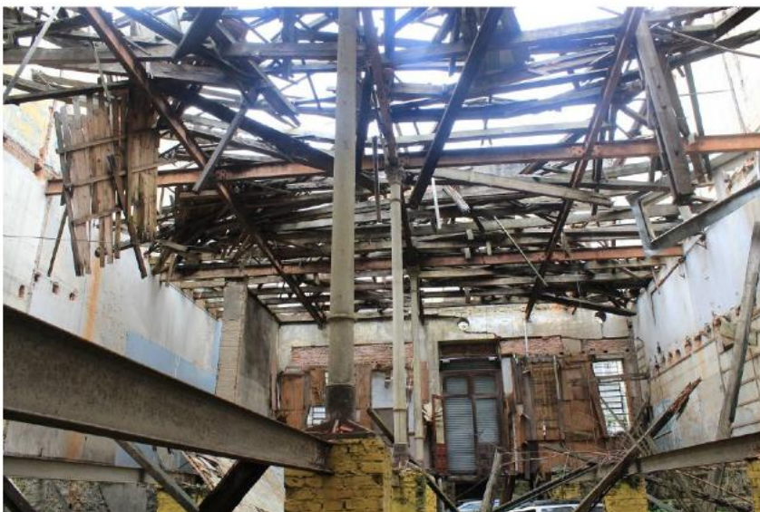
Foto 25: Madeiraamento proveniente da queda da Cobertura, apoiados precariamente sobre a estrutura metálica do Pav. Superior. Fonte: BBC Engenharia e Arquitetura Ltda.
