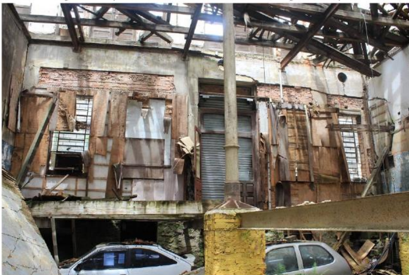
Foto 12: Chapas de compensado fixados nas paredes, bem como barrotes remanescentes dos antigos pisos. Fonte: BBC Engenharia e Arquitetura Ltda.
