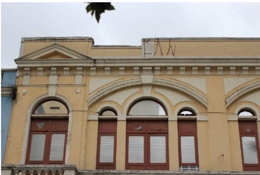
Foto 13: Esquadrias de madeira do Pav. Superior da fachada da Edificação de nº 174 (amarela). Fonte: BBC Engenharia e Arquitetura Ltda.
