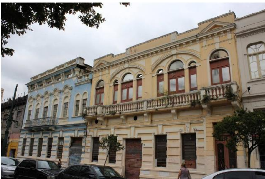
Foto 01: Alvenaria de tijolos e rebocos externos bem conservados. Fonte: BBC Engenharia e Arquitetura Ltda.
