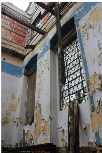
Foto 21: Descolamento da pintura látex sobre a pintura cal. Fonte: BBC Engenharia e Arquitetura Ltda.
