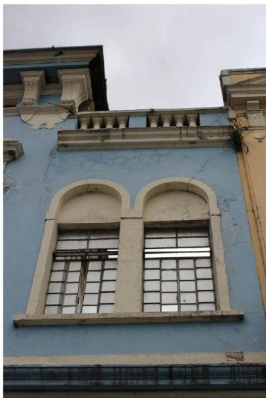
Foto 07: Pequena trinca sobre o arco da janela na fachada externa. Fonte: BBC Engenharia e Arquitetura Ltda.
