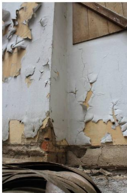
Foto 22: Descolamento da pintura látex sobre pintura a cal. Fonte: BBC Engenharia e Arquitetura Ltda.
