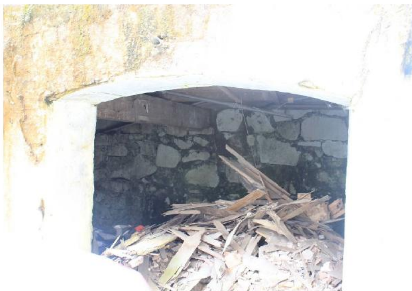
Foto 30: Fundação de pedras argamassadas com acúmulo de umidade. Fonte: BBC Engenharia e Arquitetura Ltda.
