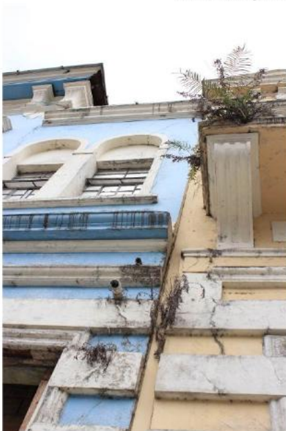
Foto 05: Presença de vegetação e tubulação elétrica antiga. Fonte: BBC Engenharia e Arquitetura Ltda.
