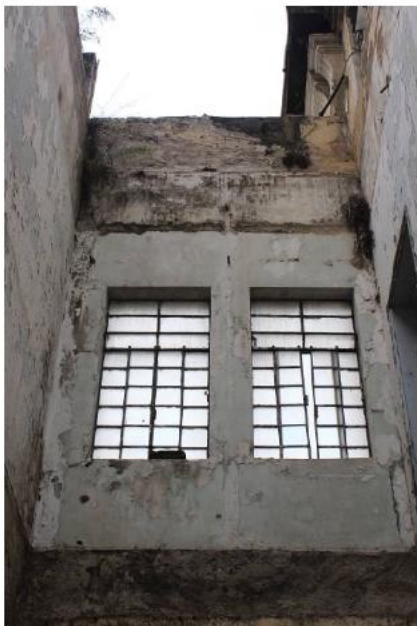
Foto 18: Esquadrias de ferro entre as duas fachadas. Fonte: BBC Engenharia e Arquitetura Ltda.
