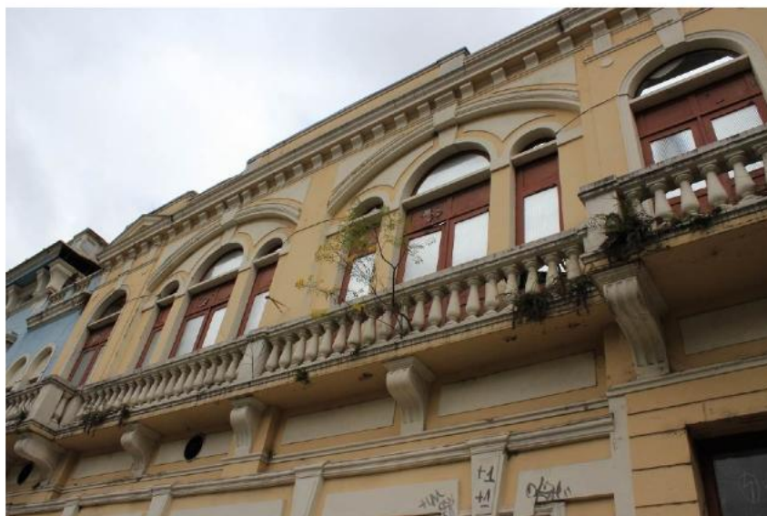
Foto 09: Trinca na moldura de coroamento do piso do balcão. Fonte: BBC Engenharia e Arquitetura Ltda.
