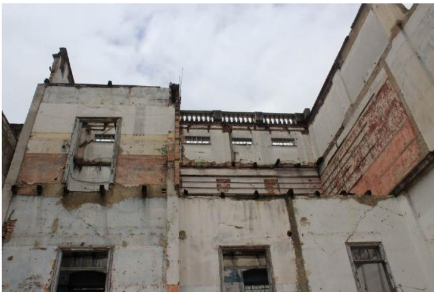
Foto 02: Rebocos faltantes na região do engaste dos pisos e da cobertura (nº 182 – azul). Fonte: BBC Engenharia e Arquitetura Ltda.
