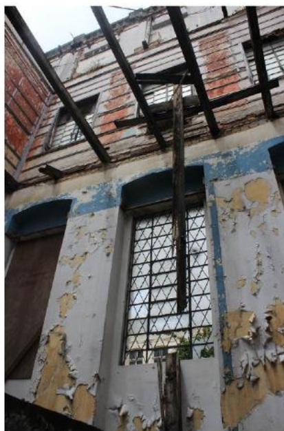
Foto 11: Barrotes de madeira engastados na fachada. Fonte: BBC Engenharia e Arquitetura Ltda.
