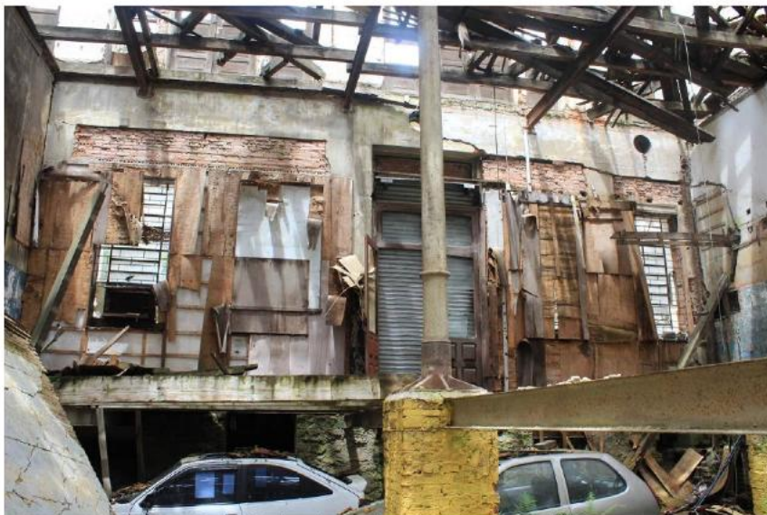
Foto 03: Região acima das janelas com reboco faltante. Fonte: BBC Engenharia e Arquitetura Ltda.
