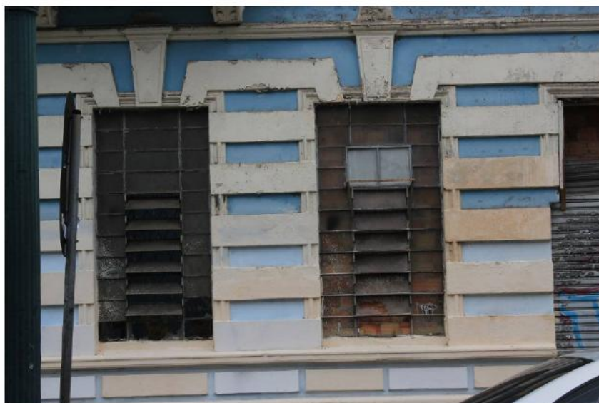
Foto 17: Esquadrias de ferro oxidadas, com vidros faltantes e alterações para equipamentos de ar condicionado. Fonte: BBC Engenharia e Arquitetura Ltda.
