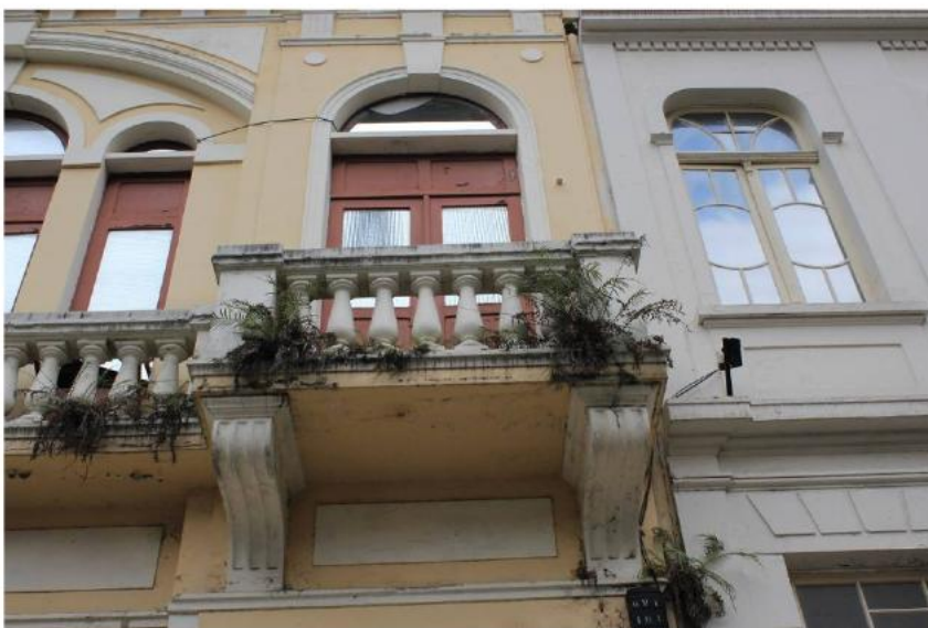
Foto 04: Presença de vegetação na fachada externa. Fonte: BBC Engenharia e Arquitetura Ltda.
