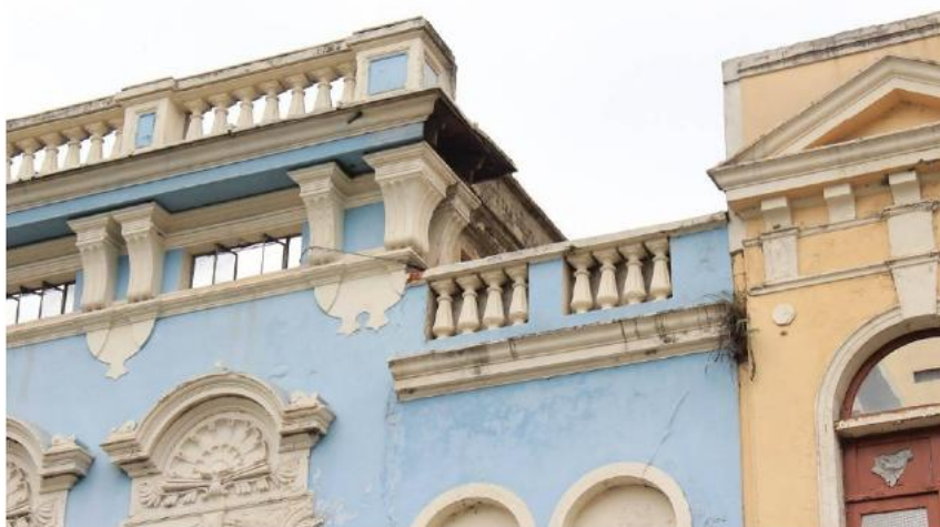
Foto 08: Pedaco faltante da cimalha de madeira com cobertura em chapa metálica. Fonte: BBC Engenharia e Arquitetura Ltda.
