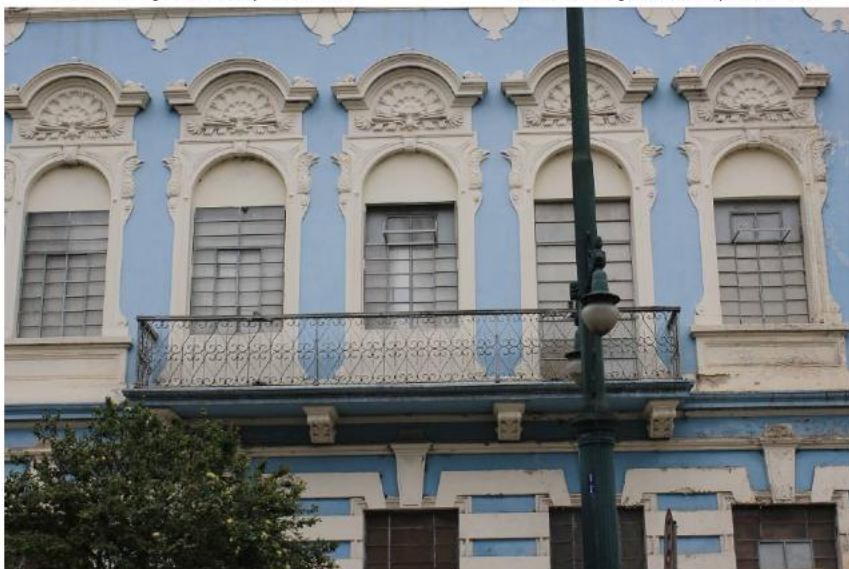
Foto 20: Esquadrias de ferro do Pav. Superior (Edificação nº 182 – azul) em bom estado de conservação. Fonte: BBC Engenharia e Arquitetura Ltda.
