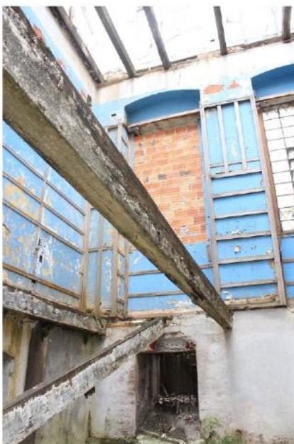
Foto 10: Engradamento de madeira fixo nas paredes da Fachada. Fonte: BBC Engenharia e Arquitetura Ltda.
