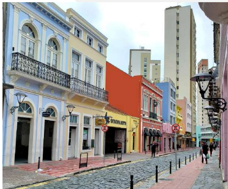
RUA SÃO FRANCISCO
