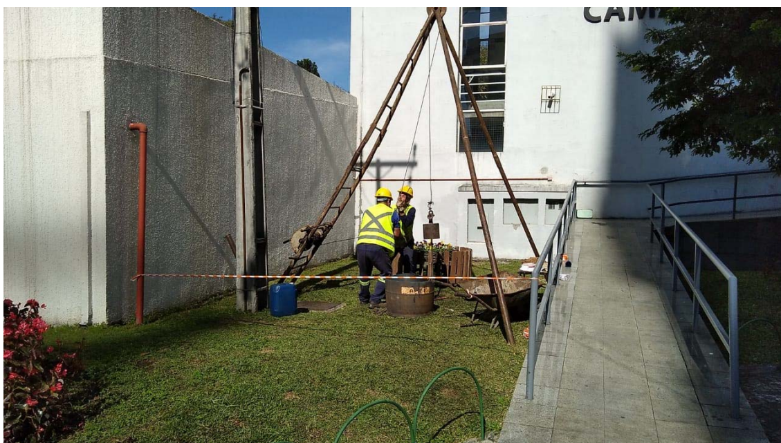
Foto 04 – Outra imagem da perfuração do furo SP-02. Foto Alexandre.
