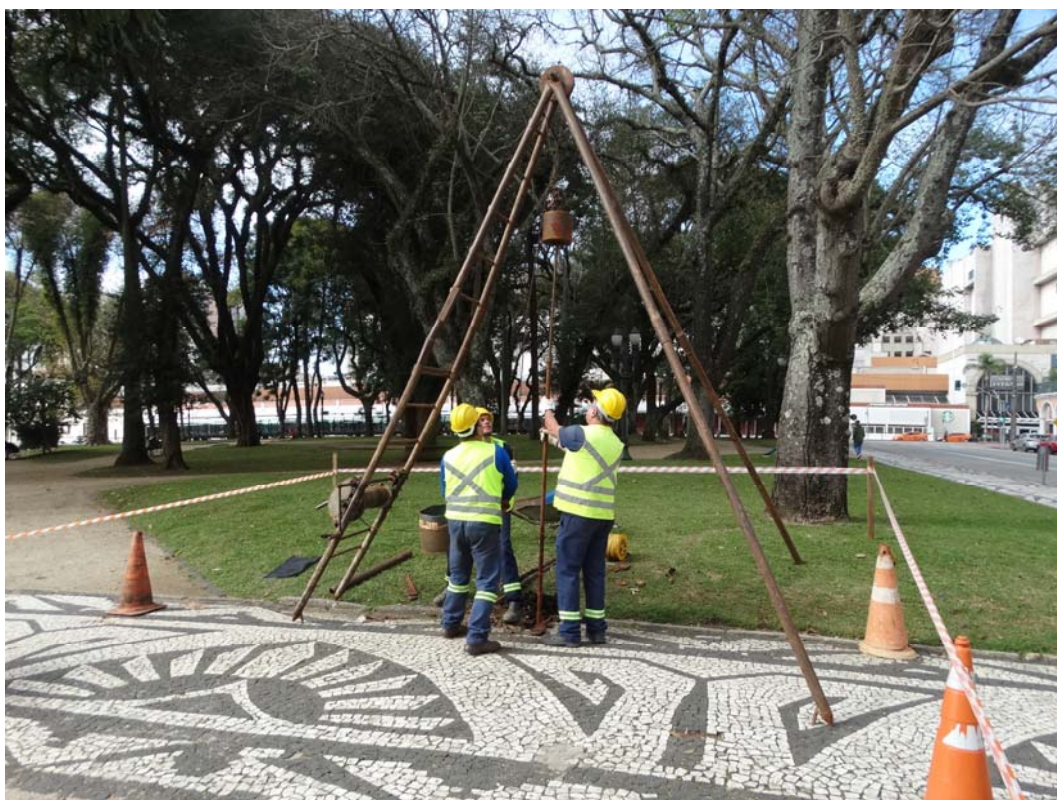
Foto 16 – Outra imagem da perfuração do furo SP-08. Foto do autor.
