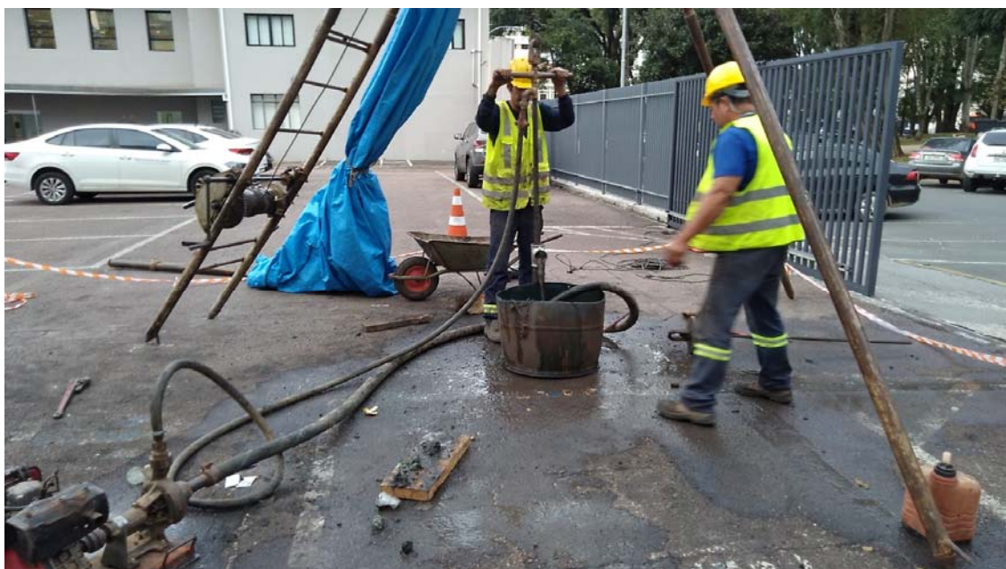
Foto 12 – Outra imagem da perfuração do furo SP-06 através da técnica da lavagem contínua, utilizada ao final do furo. Foto do autor.
