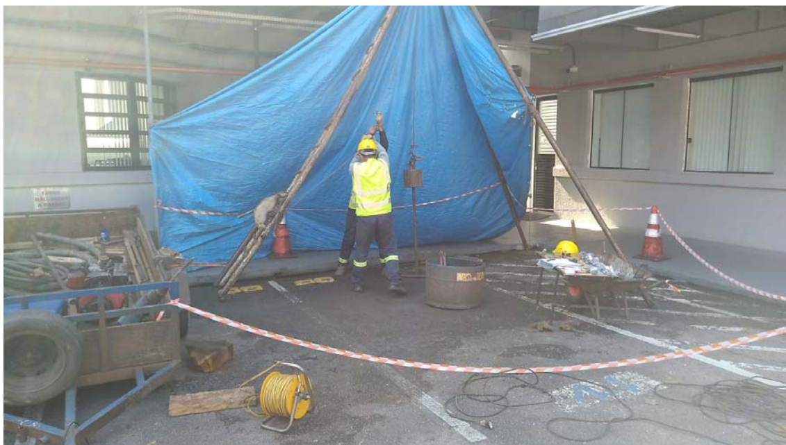
Foto 07 – Outra imagem da perfuração do furo SP-04. Foto Alexandre.
