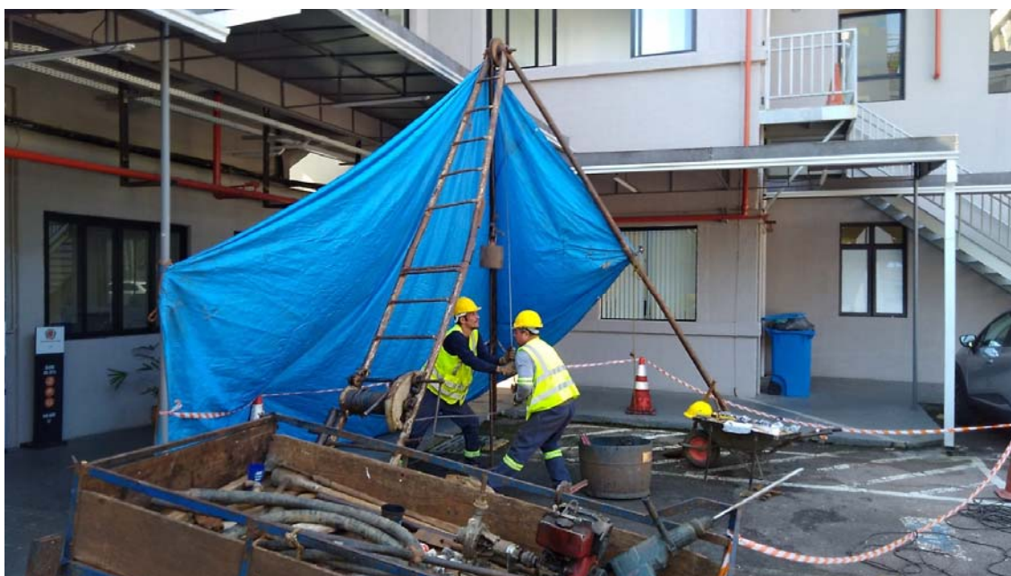
Foto 06 – Perfuração da sondagem SP-04. Foto Alexandre.
