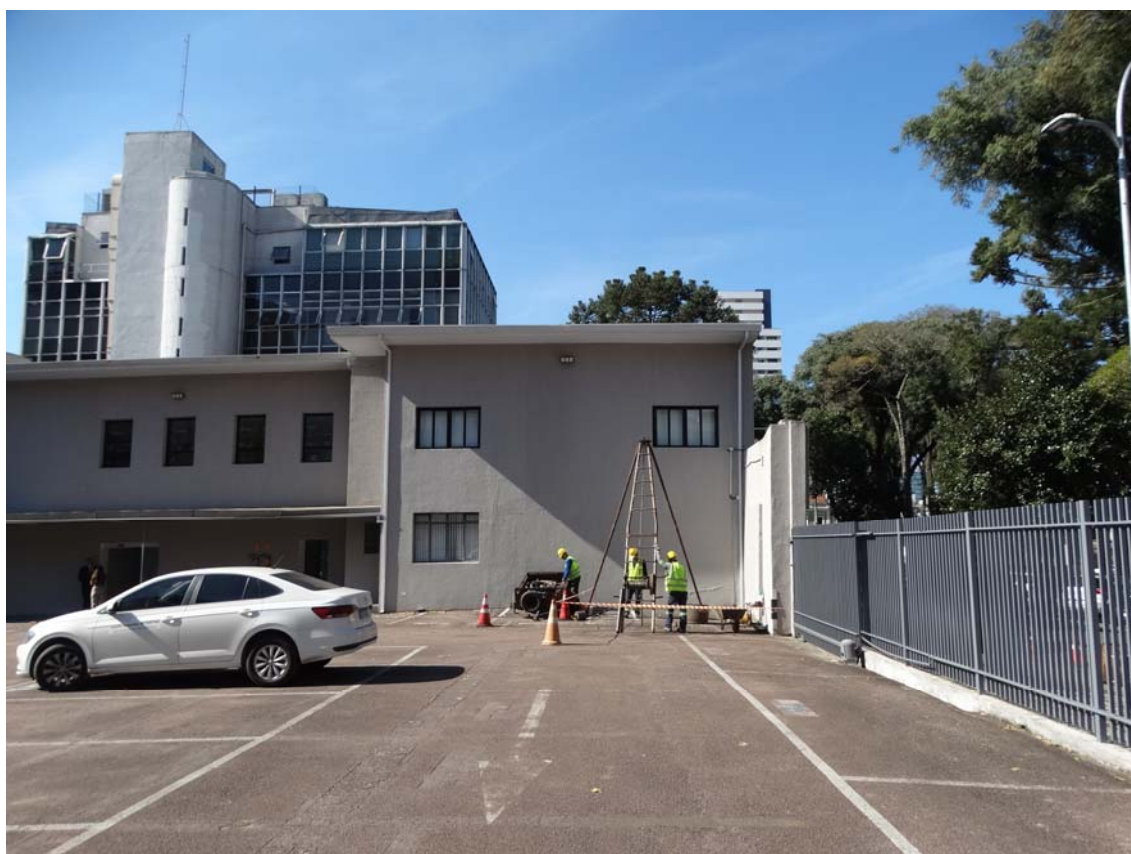
Foto 08 – Preparação para início da perfuração da sondagem SP-05. Foto do autor.
