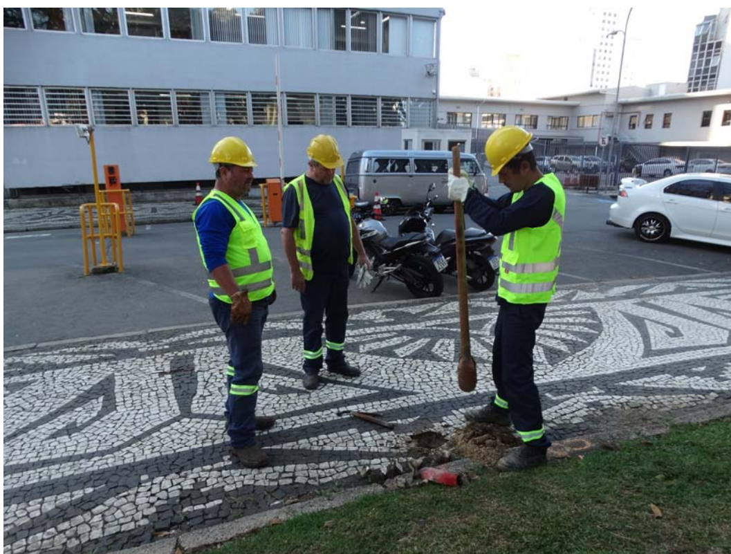
Foto 15 – Início dos serviços para realização da sondagem SP-08. Foto do autor.
