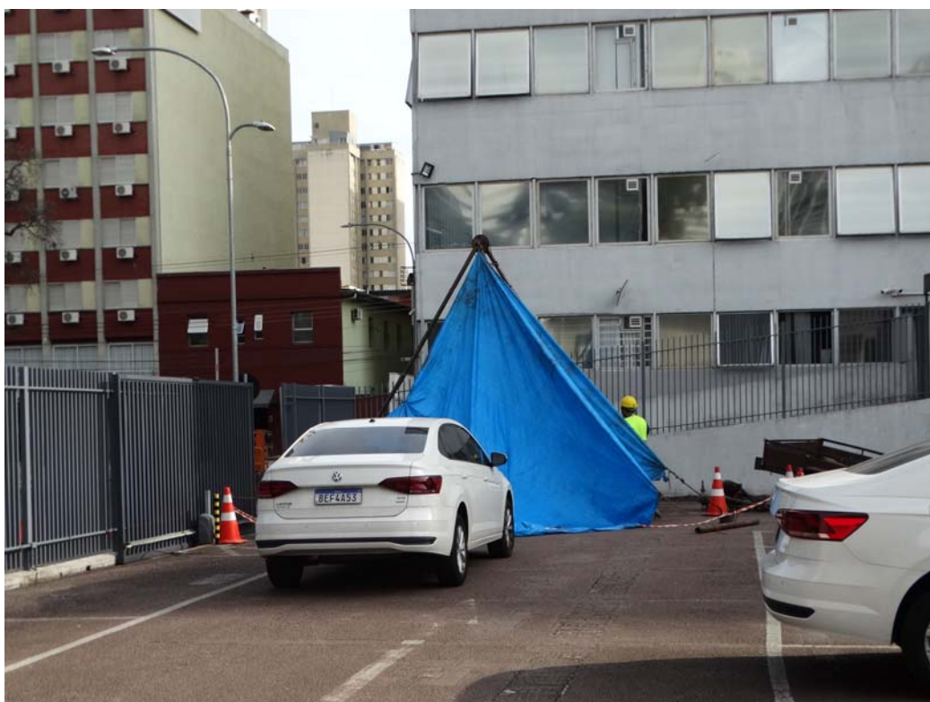
Foto 10 – Perfuração da sondagem SP-06. A lona azul tem função de proteger os veículos estacionados próximos, de eventuais fragmentos que pudessem saltar nos veículos durante os serviços de perfuração. Foto do autor.
