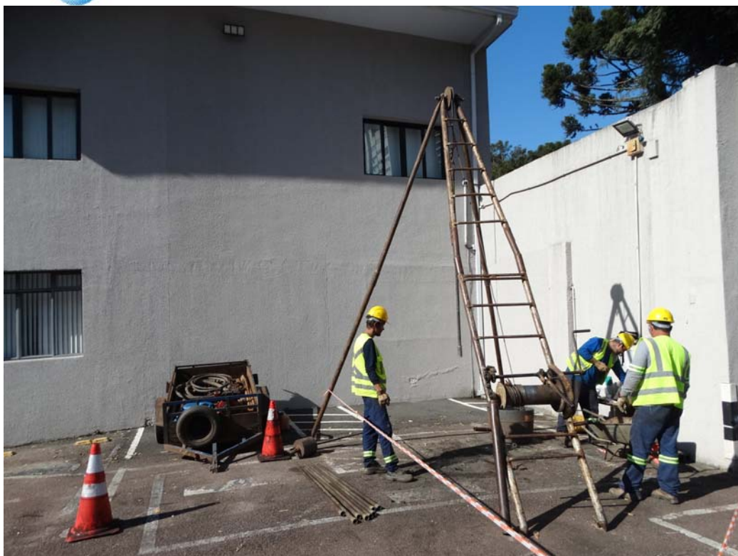
Foto 09 – Outra imagem da perfuração do furo SP-05, nesta imagem se observa a operação de remoção das hastes e do amostrador bipartido. No piso se encontram oito hastes já removidas, aonde cada uma possui, 2,0 metros de comprimento. Foto do autor.
