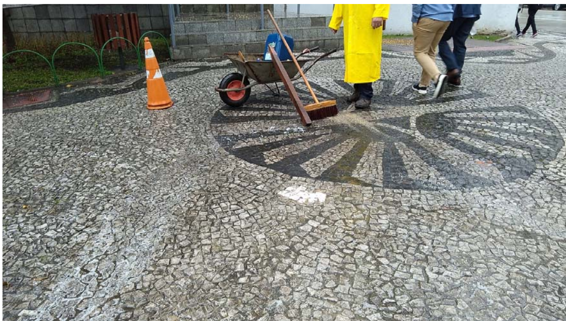
Foto 19 – Recomposição do piso aonde foi executada a sondagem SP-01 , com recolocação do paver, após termos encerrado as perfurações, amostragens e entupimento dos furos. Foto Alexandre.
