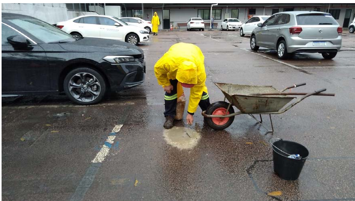
Foto 20 – Recomposição do piso aonde foi executada a sondagem SP-06 , com recolocação do paver, após termos encerrado as perfurações, amostragens e entupimento dos furos. Foto Alexandre.
