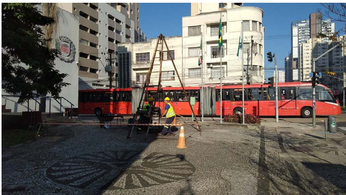
Foto 02 – Outra imagem da perfuração do furo SP-01. Foto Alexandre.
