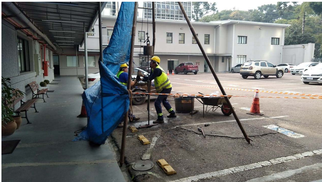
Foto 05 – Perfuração do furo SP-03. Foto Alexandre.
