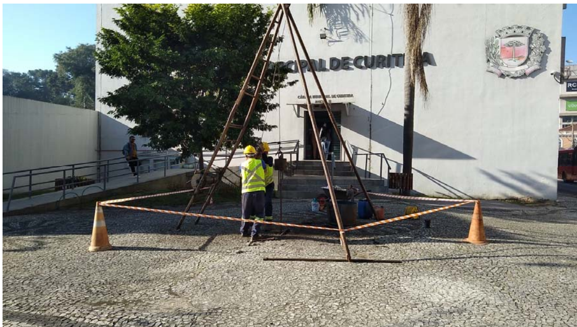
Foto 01 – Perfuração do furo SP-01. Foto Alexandre.
