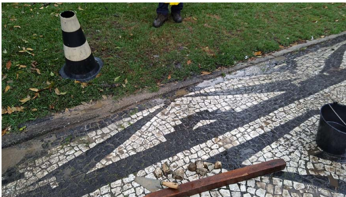
Foto 21 – Recomposição do piso aonde foi executada a sondagem SP-08 , com recolocação do paver, após termos encerrado as perfurações, amostragens e entupimento dos furos. Foto Alexandre.
