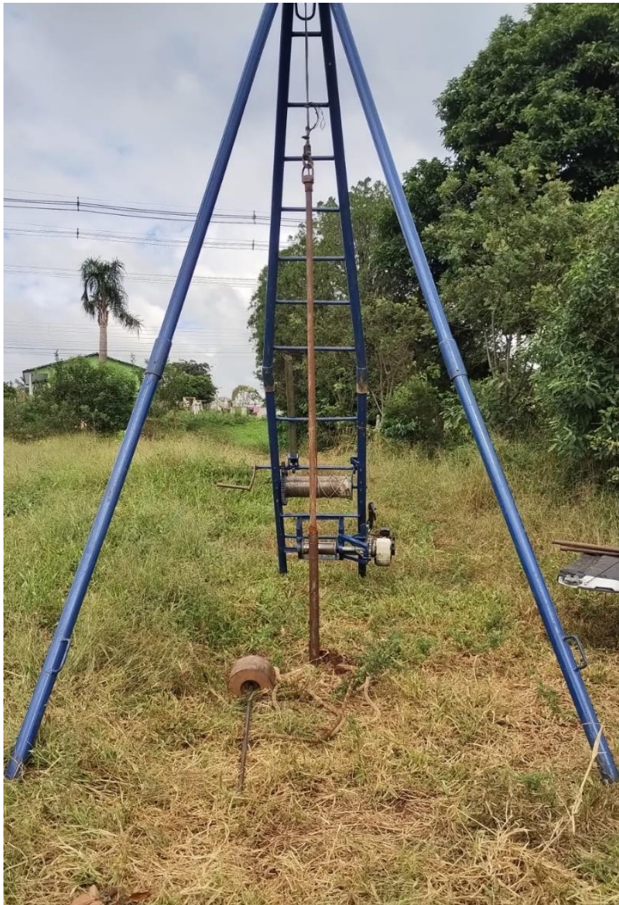
Figura 4 – Levantamento em campo – SPT 02, fonte: do autor, 2025.
