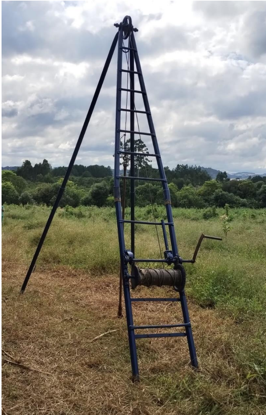
Figura 5 – Levantamento em campo – SPT 03, fonte: do autor, 2025.
