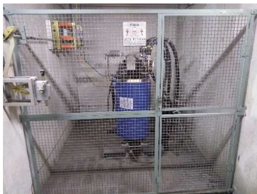
Figura 7 – Transformador 500kVA
