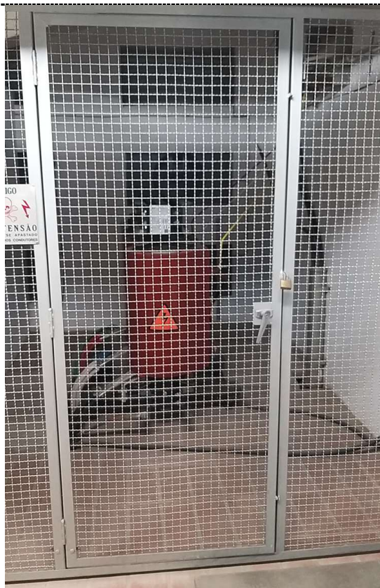
FIGURA 1 - TRANSFORMADOR 300 kVA
