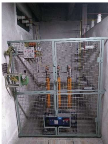
Figura 10 – Seccionadora MT
