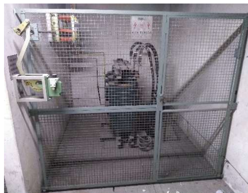
Figura 8 – Transformador 225kVA
