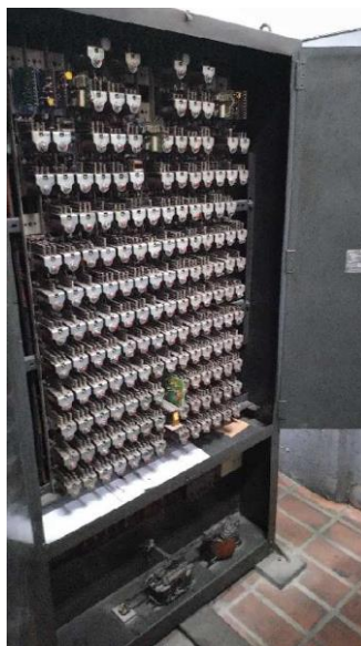
Figura 4 – Lógica analógica para andares e Quadros de comando
