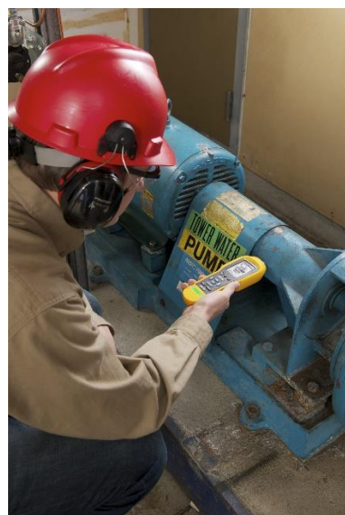
Inspeção de vibração de motores
