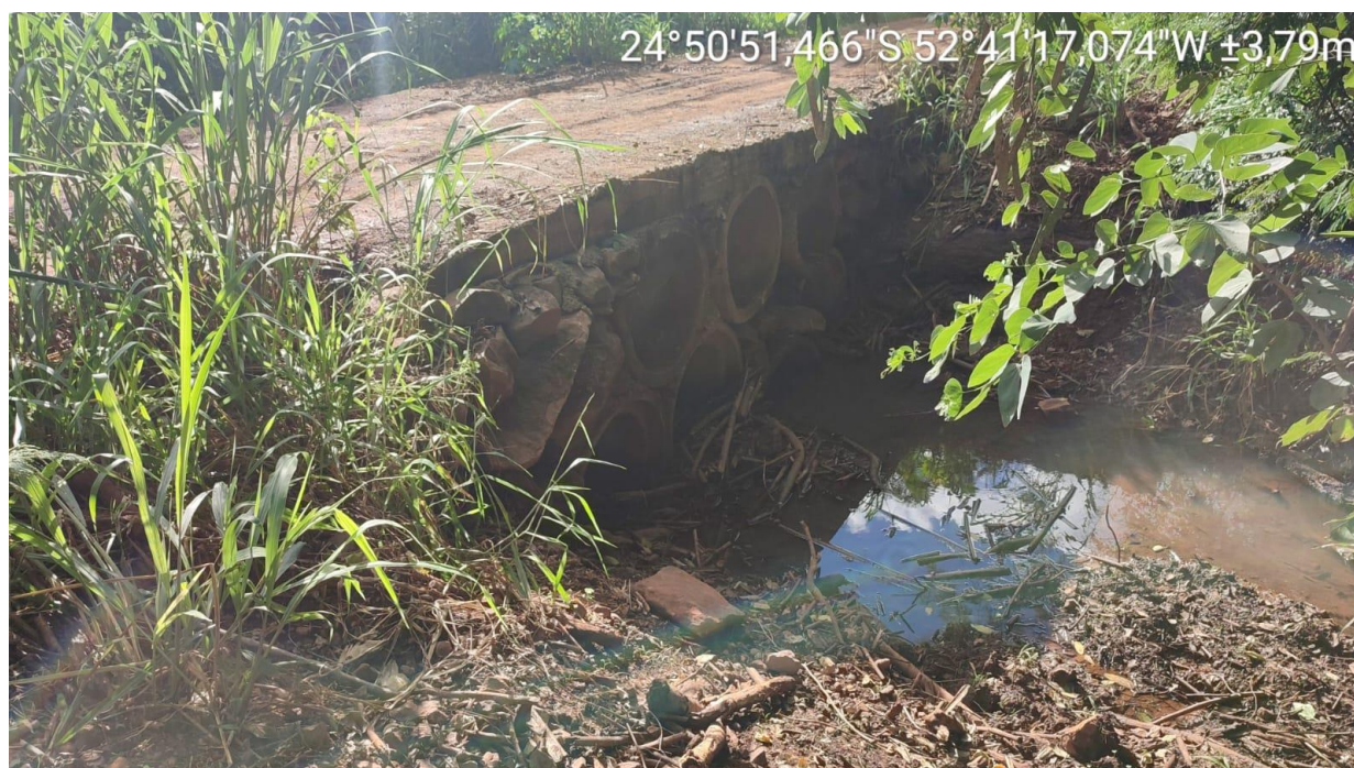
Figura 3 – Travessia existente no rio Bela Fonte.
