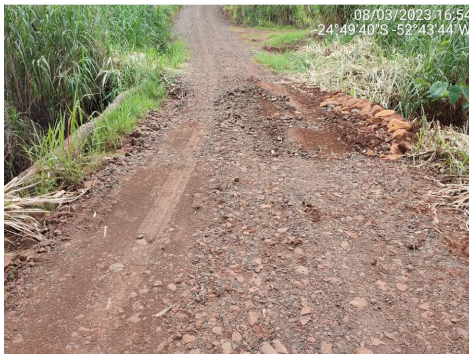
Figura 3 – Travessia existente no rio Pingo de Ouro.
