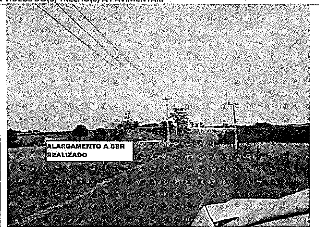
estaca 298 sentido início do trecho, alargamento a ser executado em contrato em andamento, capa sobre pavimento existente
