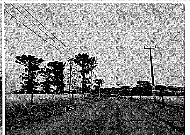
estaca 259 sentido início do trecho, contrato vigente com base e sub-base do alargamento já executado, aguardando capa, lado direito a ser recapeado
