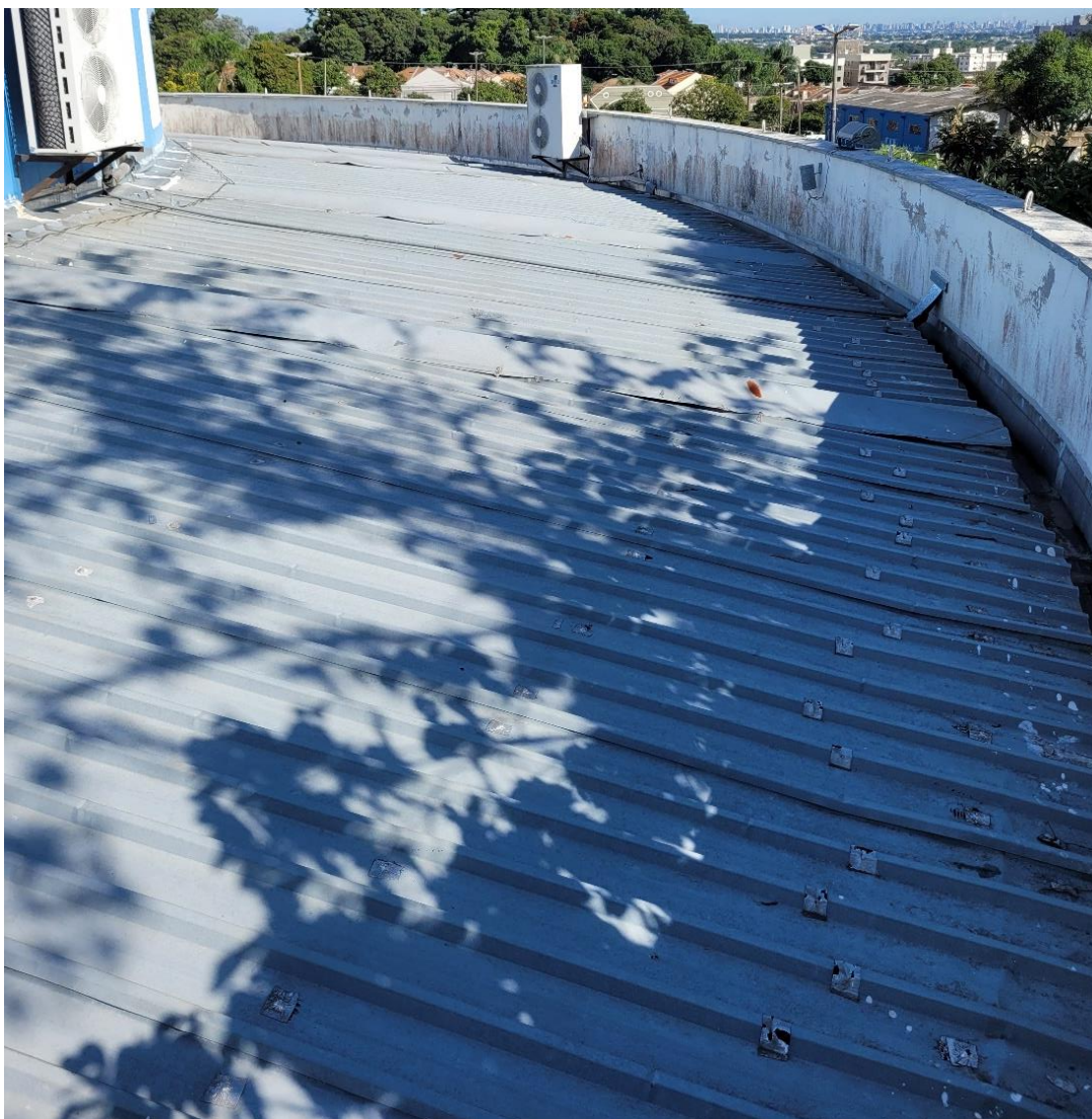
Fotografia 05 – vista 2 da cobertura inferior do plenário
