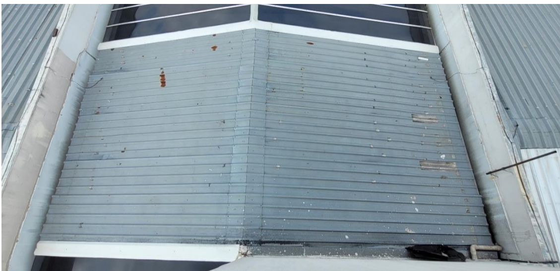
Fotografia 03 – vista geral da cobertura central do edifício principal
