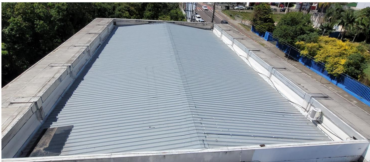
Fotografia 02 – vista geral da cobertura maior do edifício principal
