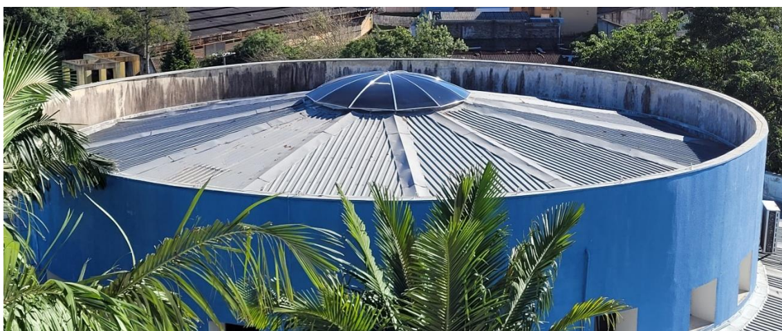
Fotografia 06 – vista geral da cobertura superior do plenário
