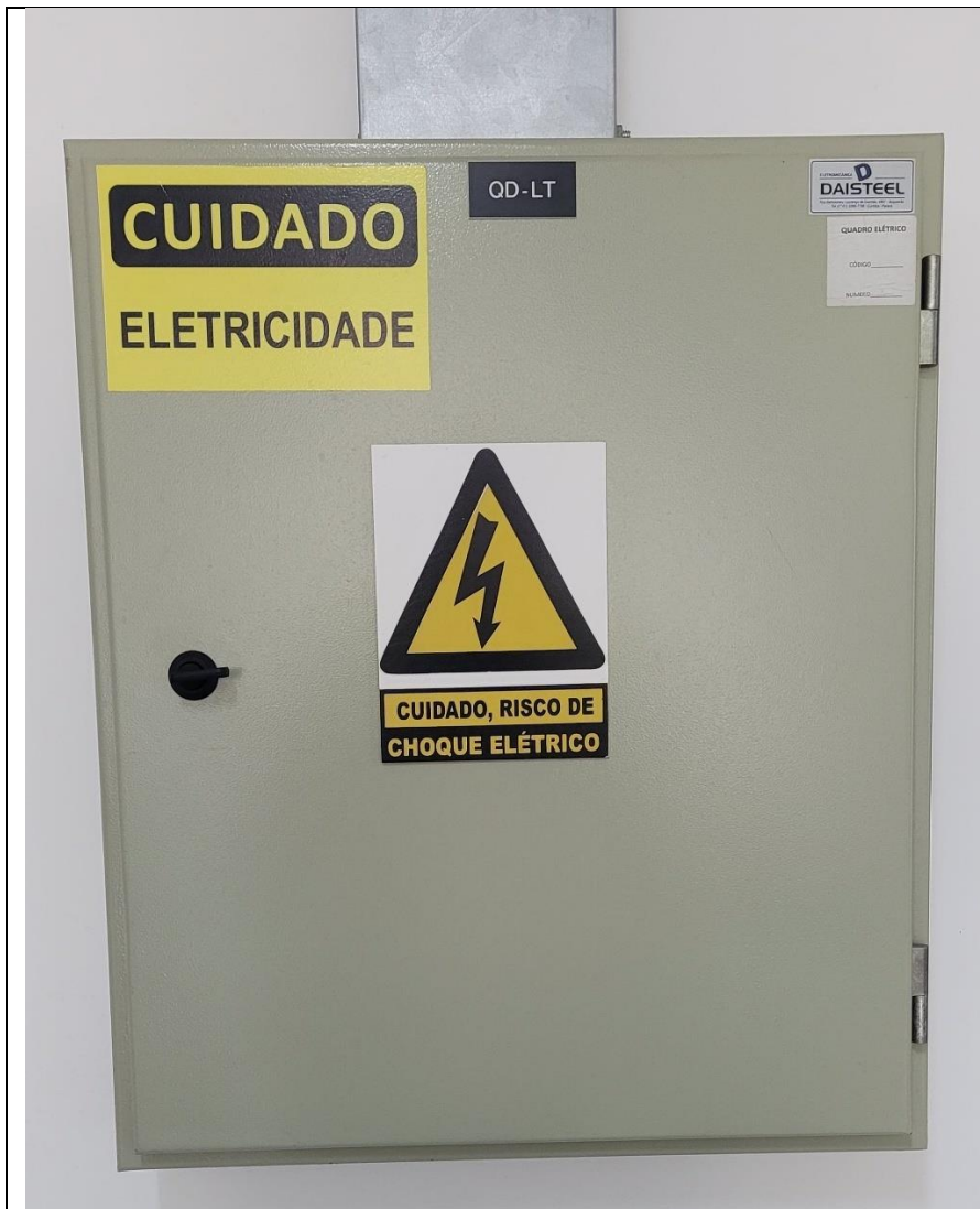
Fotografia 1 – Modelo de quadro de distribuição fechado
