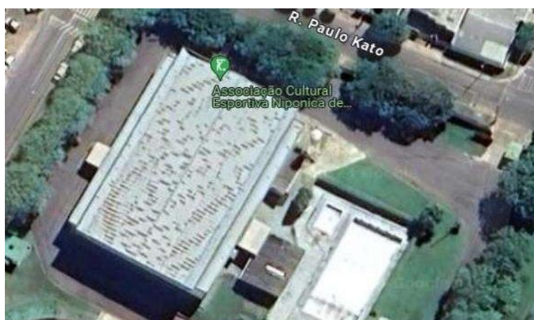
Figura 2 – Vista da ACENG.
