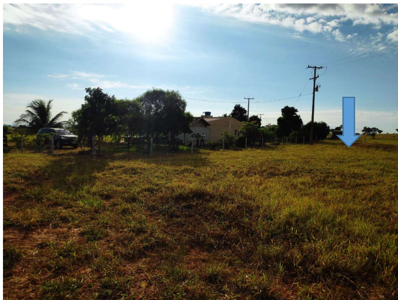
Vista do local de instalação sentido a direção da Cidade de Douradina Obs.: sombra na imagem proveniente do almoxarifado existente
